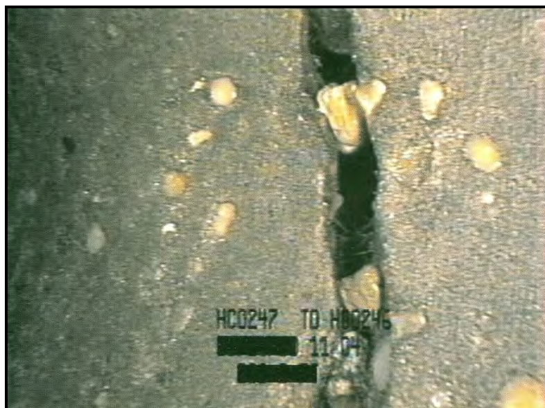
شکل ۶-۱۰-ج - آسیب سطحی، نمایان شدن سنگدانه‌ها در ساعت ۱۲
