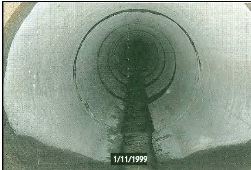
شکل ۶-۱۲-ب- نشتاب از نوع چکیدن (ID) در ساعت ۱۲
