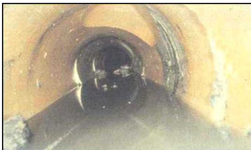
شکل ۶-۱۹- اتصال فاضلابروی جانبی در موقعیت ساعت ۱
