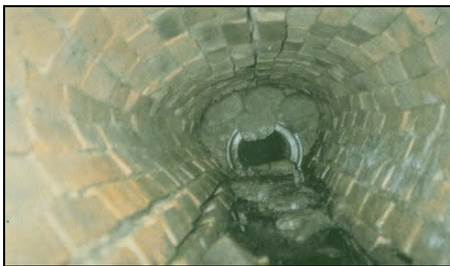
شکل ۶-۲۳- تغییر در شکل فاضلابرو به مقطع دایروی
