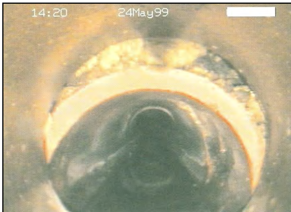
شکل ۶-۸-ب - جابجایی در محل اتصال
