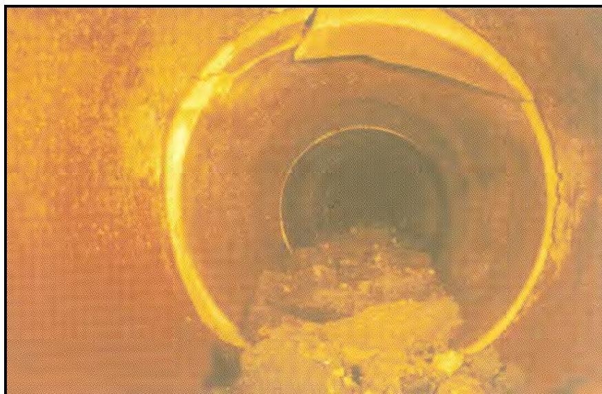
شکل ۶-۱۶- رسوبات ته‌نشین شده از نوع درشت دانه و ۱۰٪ کاهش سطح مقطع
