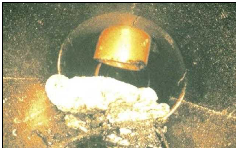
شکل ۶-۲۰-الف- انشعاب مهاجم (Intruding Connection) در ساعت ۱۲
