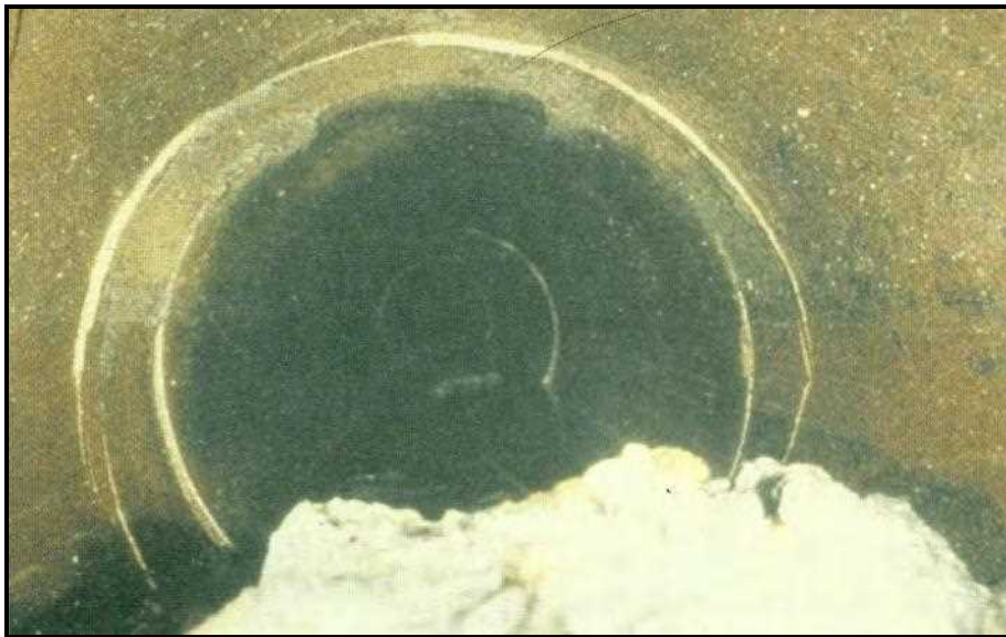
شکل ۶-۲-ب - ترک پیرامونی (CC) از ساعت ۸ تا ساعت ۵
