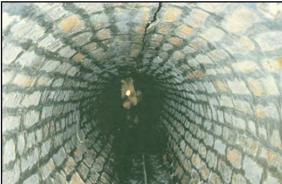
شکل ۶-۳-ب - شکاف طولی (FL) در ساعت ۱
