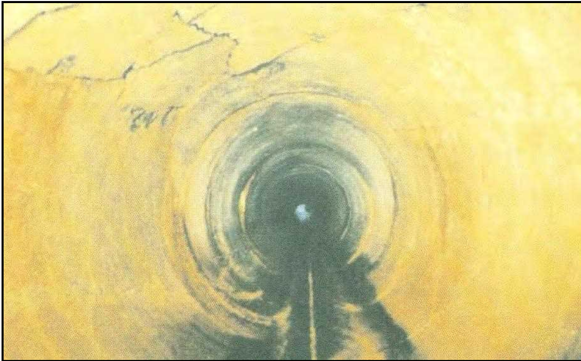
شکل ۶-۳-ج- شکاف‌های چندگانه (FM) از ساعت ۱۰ تا ساعت ۲
