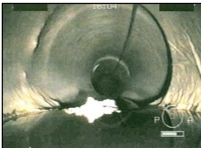
شکل ۶-۲۲ الف - جمع‌شدگی پیرامونی در روکش داخلی از ساعت ۷ تا ۵
