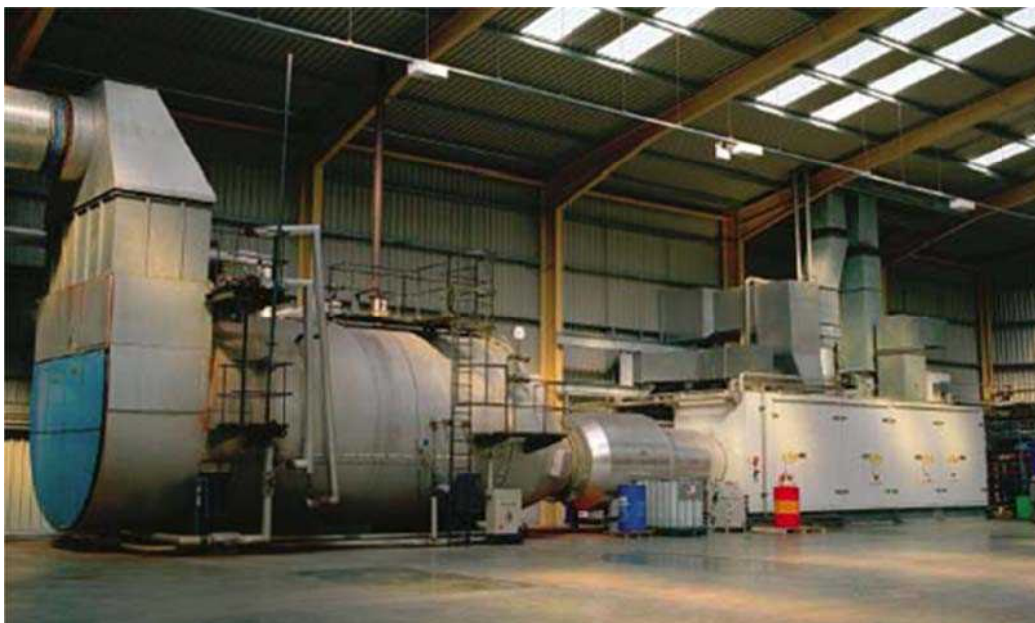
شکل ۲-۶- یک نمونه واحد تولید همزمان توربین گاز در کشور آلمان
