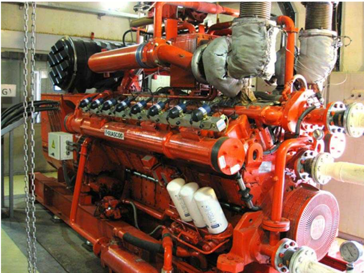
شکل ۲۴-۴- موتور GUASCOR مدل SFGM 560 در CHP پروژه شماره ۹
