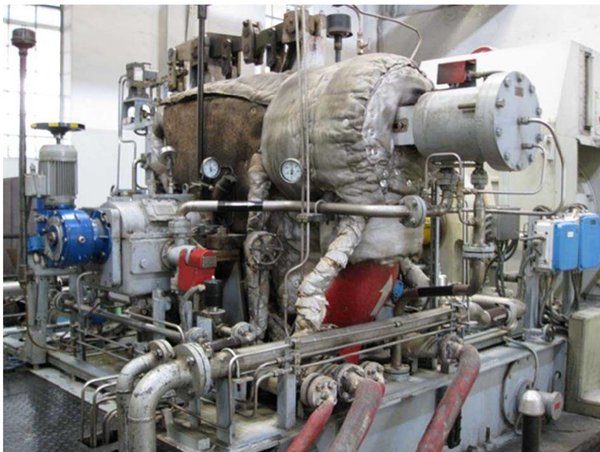
شکل ۱-۴- توربین بخار پس فشاری
