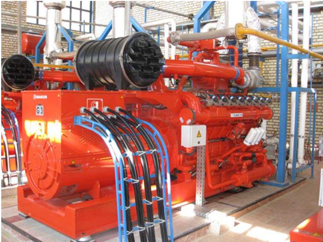
شکل ۴-۱۰- موتور GUASCOR مدل SFGM 560 در پروژه شماره ۴
