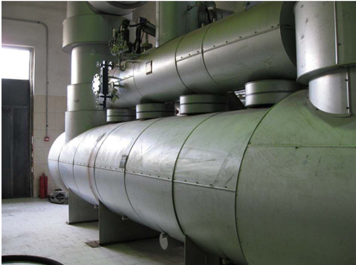
شکل ۴-۸- مبدل حرارتی جهت تولید بخار از گازهای خروجی موتور
