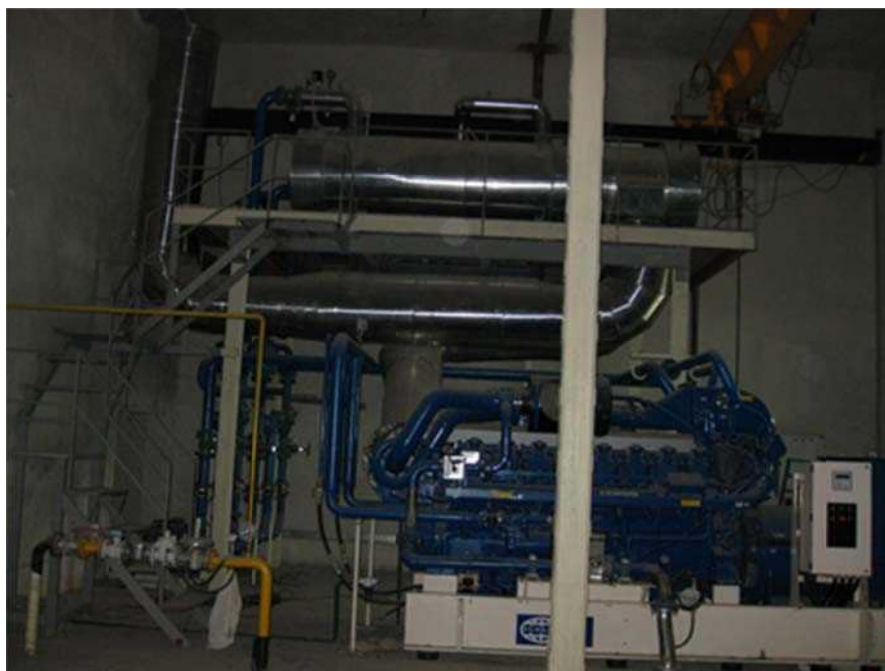
شکل ۴-۴- موتور پیستونی FG WILSON مدل PG1250B به همراه مبدل‌ها
