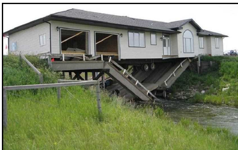
شکل ۵-۵- تخریب پل نمونه‌ای از مشکلات به وجود آمده در جابجایی ساختمان [۵۶]
