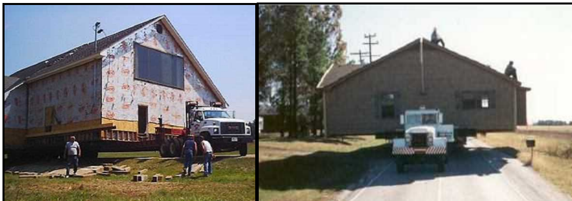
شکل ۵-۴- نمونه‌ای از اجرای تغییر مکان ساختمان موجود [۵۶]
