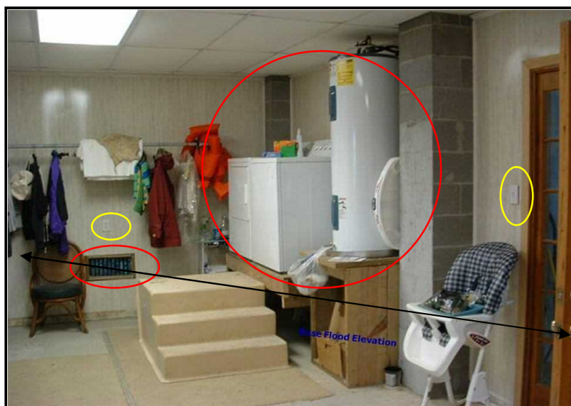
شکل ۳-۶- نمونه‌ای از روش پادسیل سازی مرطوب، همان‌طور که در تصویر مشاهده می‌شود پریزهای برق و سایر وسایل بالاتر از سطح سیلاب مبنا تعبیه شده‌اند و خروجی سیلاب (کنار صندلی) برای تخلیه سیلاب در نظر گرفته شده است.
