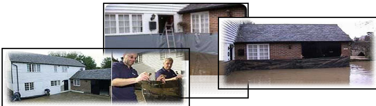
شکل ۳-۸- استفاده از پارچه‌های ضدسیلاب در پادسیل‌سازی خشک [۳۸]
