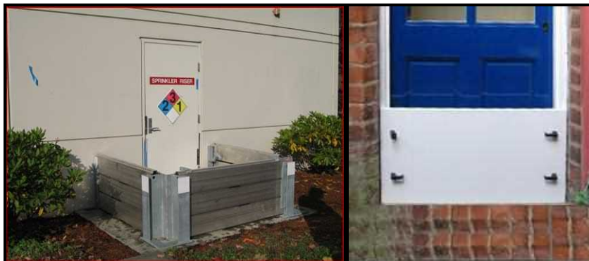
شکل ۵-۷- نمونه‌ای از آب‌بندهای دائمی پنجره و درب انبار مواد شیمیایی [۶۴]
