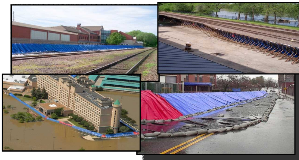
شکل ۳-۹- استفاده از پارچه‌های ضدسیلاب به عنوان کمک کننده (پوشش‌دهنده خاکریزها) [۴۷]
