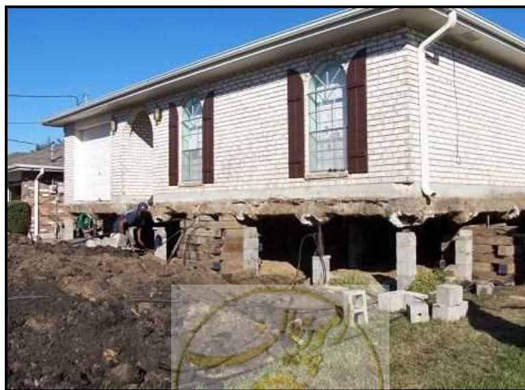
شکل ۵-۱- نمونه‌ای از اجرای مرتفع‌سازی ساختمان موجود [۵۶]
