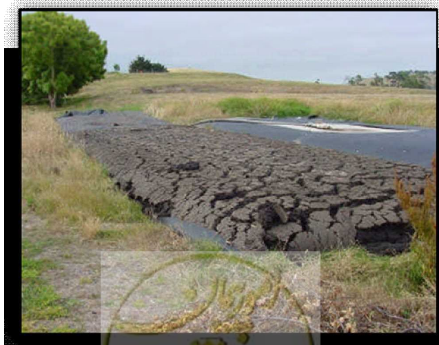
شکل ۱۲-۲- کیسه‌های ژئوبگ پس از دو هفته خشک شدن مواد درون آن
