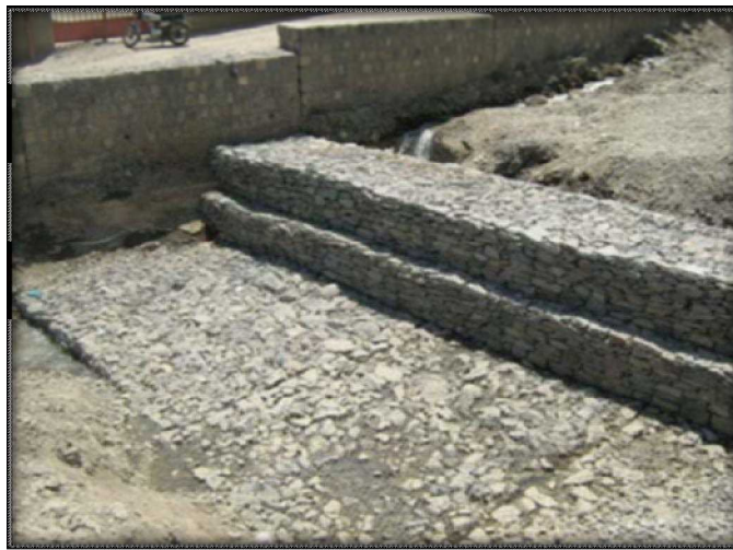
شکل ۱-۱- نمونه‌ای از کف‌بند توری سنگی در کنار دیواره سنگی [۱۳]
