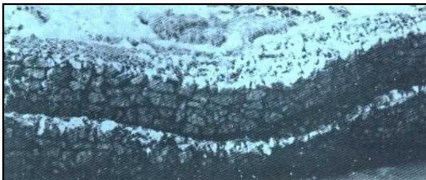
شکل ۷-۲- انعطاف‌پذیری پوشش توری‌سنگ در مقابل نشست‌های قائم [۹]
