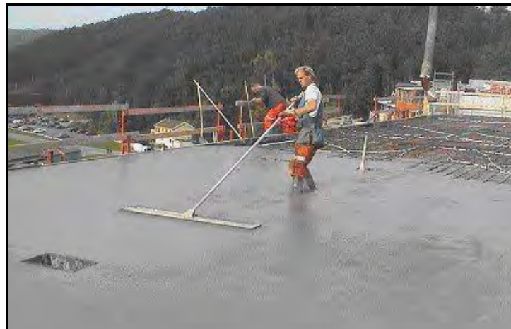
شکل پ.۲-۶- پرداخت سطح بتن خودتراکم
