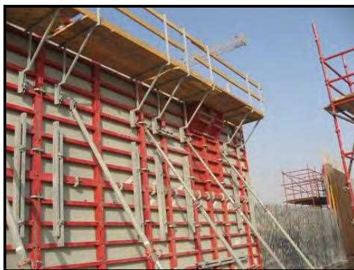
شکل ۱-۵- سیستم قالب‌بندی دیوار بتنی بلند
