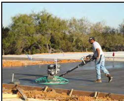
شکل ۵-۶- پرداخت سطحی کف با ماله‌ی پروانه‌ایی
