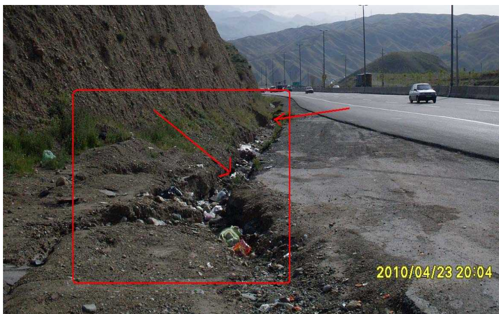
شکل پ ۷-۱ عدم وجود کانال طولی هدایت آب که منجر به خرابی کناره راه و جسم راه می گردد (مسئله آب به جسم راه نفوذ می نماید)
