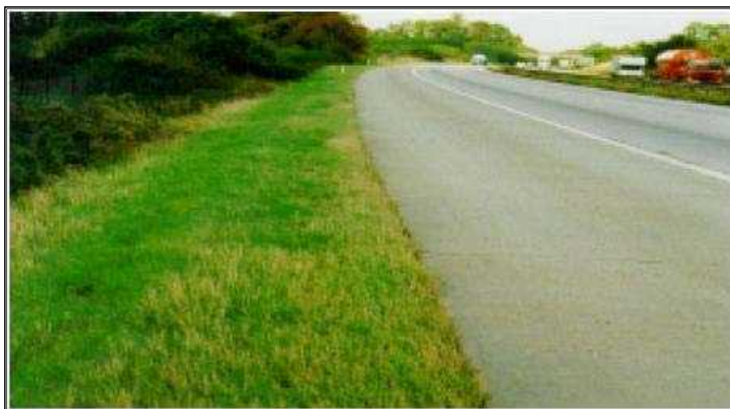
شکل ۲-۷- رشد گیاهان هرز در سیستم زهکشی سطحی لبه‌ای
