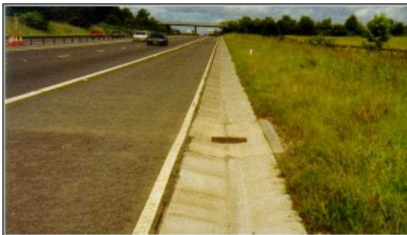
شکل ۲-۳- نمونه ای از زهکشی سطحی راه با عنوان کانال سطحی آب [۸]
