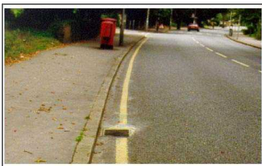
شکل ۱-۲- نمونه‌ای از زهکشی سطحی راه با عنوان مجرا و جدول [۸]
