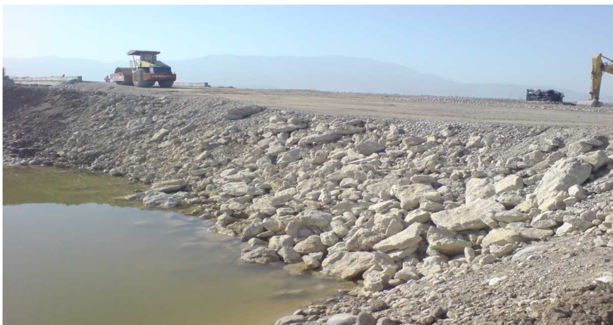
شکل پ ۱-۱۴- خاکریزی و استفاده از مصالح منتخب
