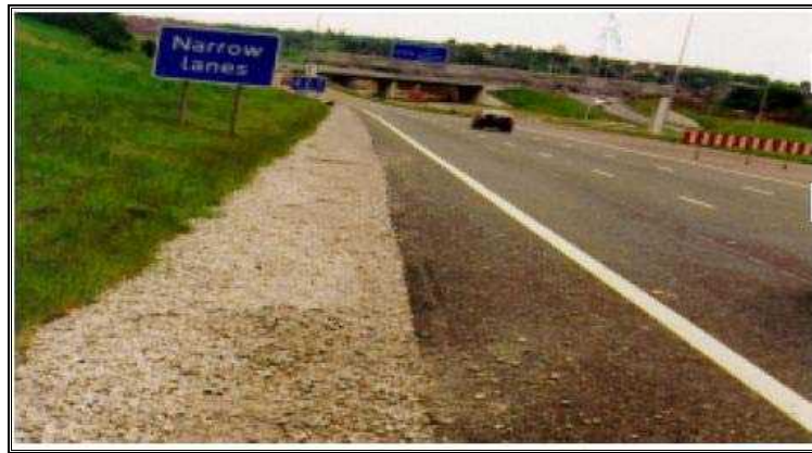
شکل ۲-۵- جزئیات و نحوه اجرای سیستم زهکشی ترکیبی (فرانسوی) [۸].
