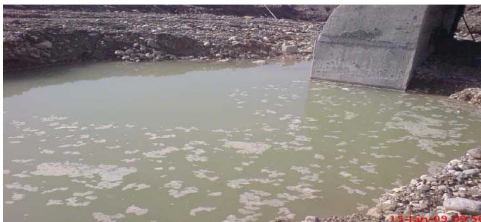
شکل پ ۱-۱۰- مشکلات حضور آب جهت اجرای ابنیه فنی.
