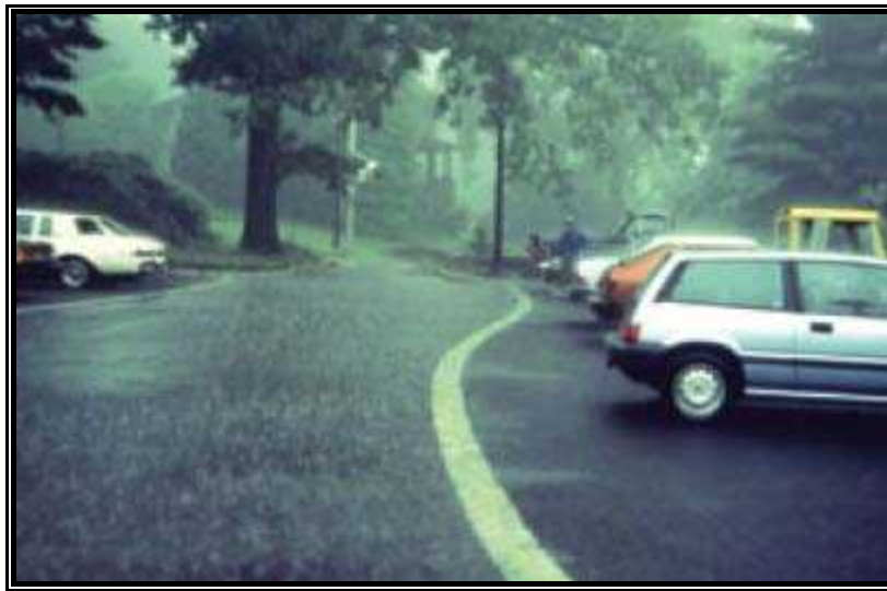
شکل ۲-۱۲- مقایسه نحوه زهکشی دو لایه آسفالت متخلخل (سمت راست تصویر) و آسفالت معمولی (سمت چپ تصویر)
