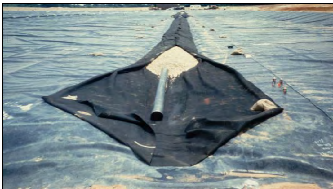
شکل ۶-۱- نمایی از مراحل کارگذاری لوله و پتوی زهکش شیرابه در کف لندفیل
