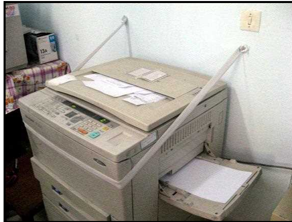
شکل ۴-۱۷- مهار مناسب دستگاه فتوکپی در مدرسه
