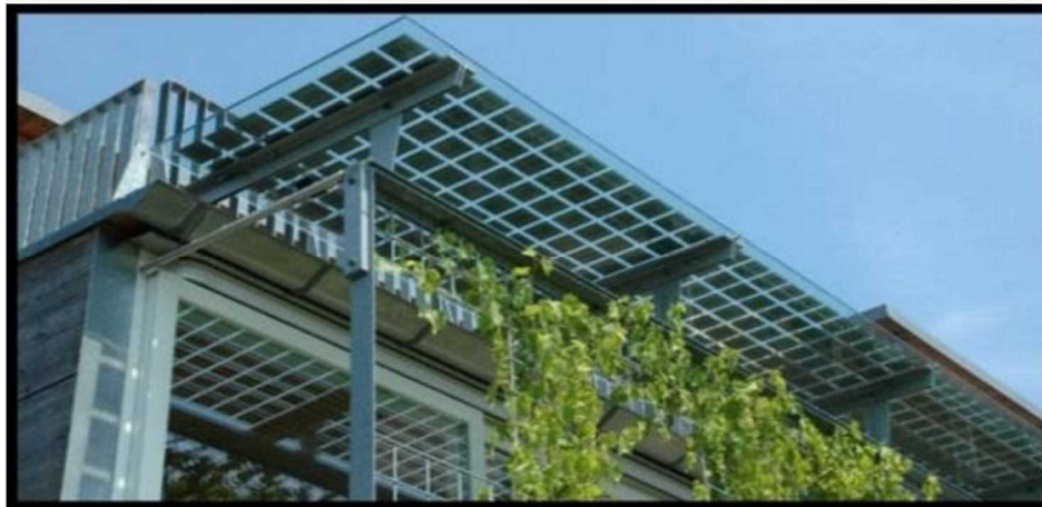
شکل (۳-۷): نصب آرایه‌های فتوولتاییک به عنوان سایه بان
