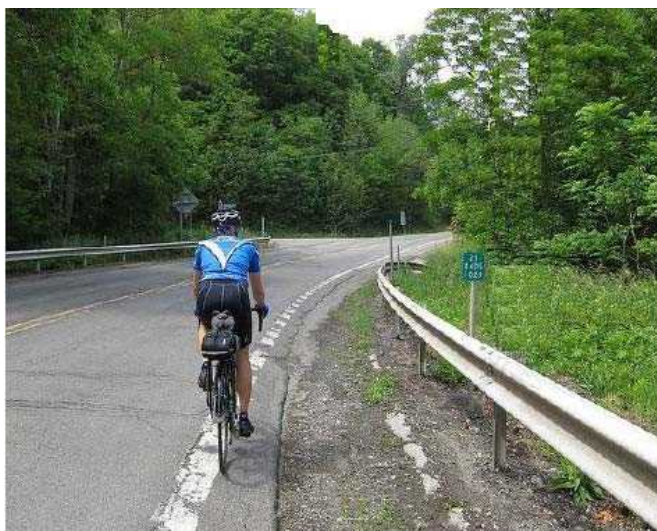
شکل ۳-۱۶- شانه نامناسب برای تردد موتورسیکلت‌رانان و دوچرخه سواران
