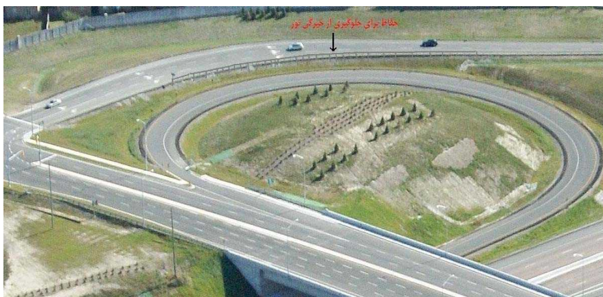
شکل ۳-۳۶- نصب حفاظ برای جلوگیری از خیرگی نور
