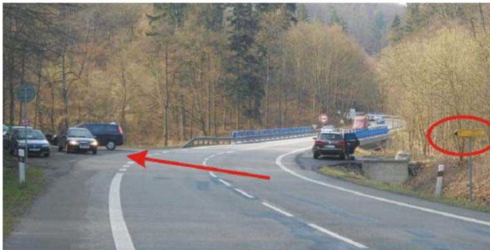
شکل ۳-۲۳- عدم دید مناسب دسترسی واقع در داخل قوس افقی
