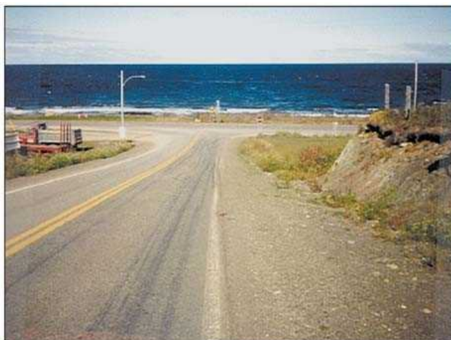
شکل ۳-۲۴- قرار گرفتن تقاطع در انتهای سرازیری تند بدون آشکارسازی مناسب
