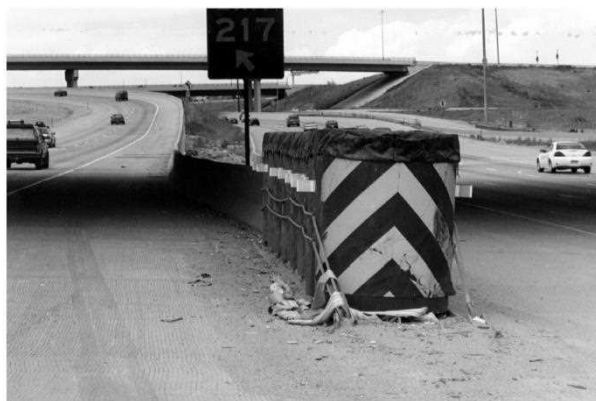
شکل پ ۳-۹- ضربه‌گیر جذبی باز کاربرد
