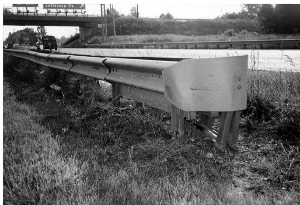
شکل پ ۳-۲- ضربه‌گیر برک ماستر ۳۵۰
