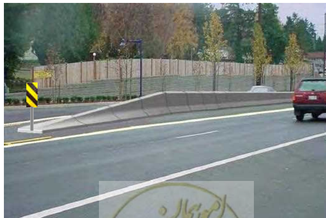
شکل ۲-۱۴- شیب‌دار کردن انتهای حفاظ بتنی
