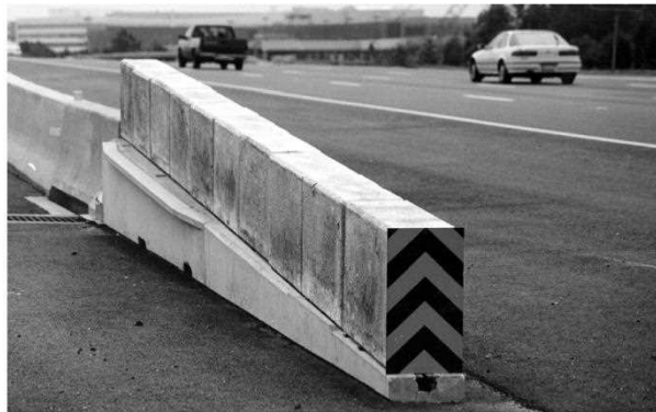
شکل پ ۳-۱- ضربه‌گیر مکمل انتهای حفاظ بتنی
