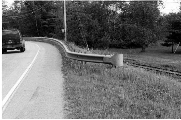
شکل پ ۲-۵- مهار انتهایی از نوع ورمونت
