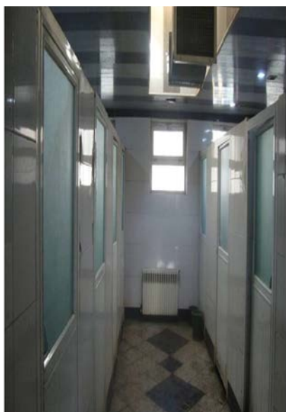
شکل پ-۹: عرض کم راهروهای داخلی در سرویس‌های عمومی بازدید شده -عدم امکان دسترسی به روشویی سرویس‌های بهداشتی برای افرادی که از صندلی چرخدار استفاده می‌کنند (شکل پ-۱۰).
