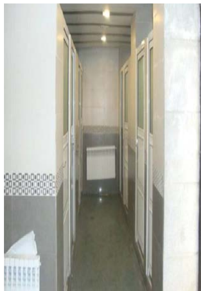
شکل پ-۹: عرض کم راهروهای داخلی در سرویس‌های عمومی بازدید شده -عدم امکان دسترسی به روشویی سرویس‌های بهداشتی برای افرادی که از صندلی چرخدار استفاده می‌کنند (شکل پ-۱۰).
