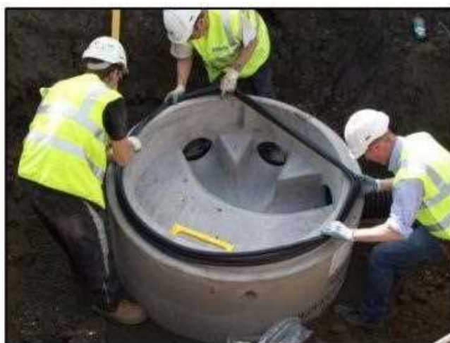
شکل ۵۰: جزییات حلقه بتنی پیش‌ساخته با واشر لاستیکی
