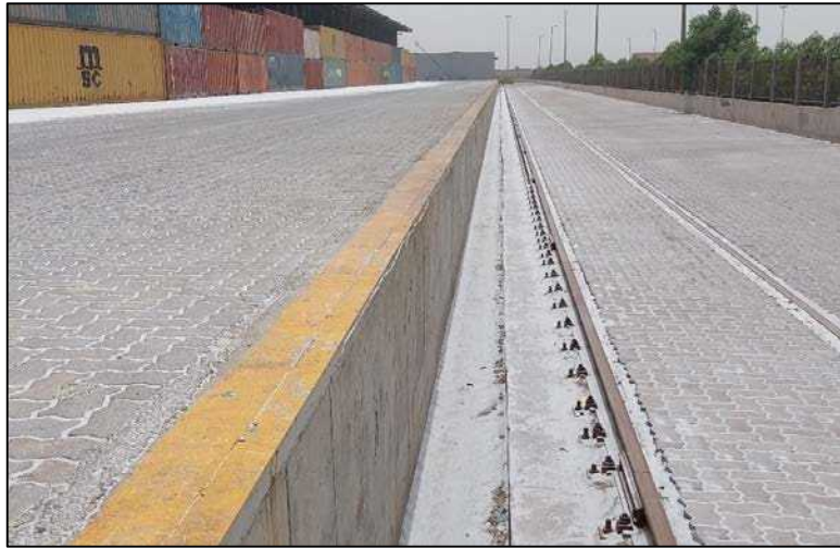
شکل ۱۶: کانال روباز مجاور خطوط ریل برای زهکشی محوطه ریلی
