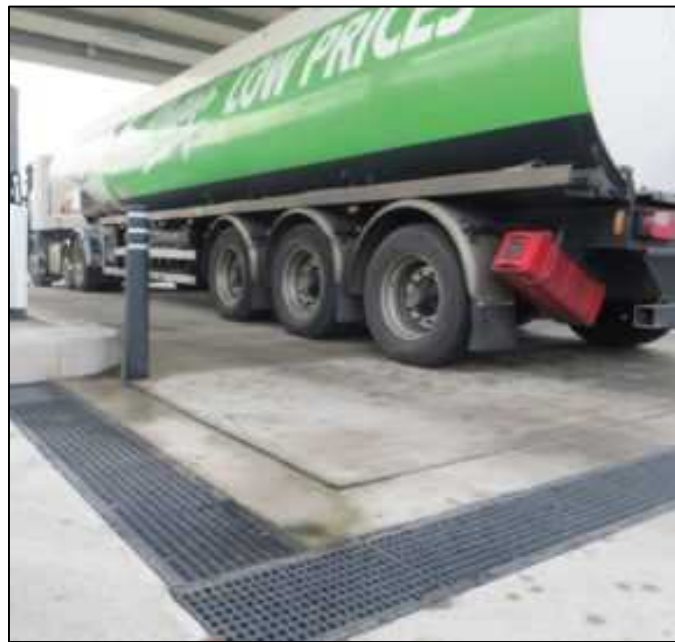
شکل ۱۸: استفاده از کانال پیش‌ساخته مشبک در مناطق سوخت‌گیری
