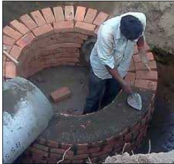
شکل ۵۱: ساخت آدم‌رو آجری
