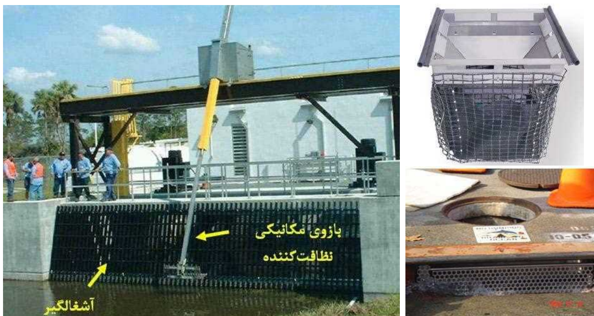
شکل ۲۵: نمونه‌ای از آشغالگیرهای سیستم‌های زهکشی
