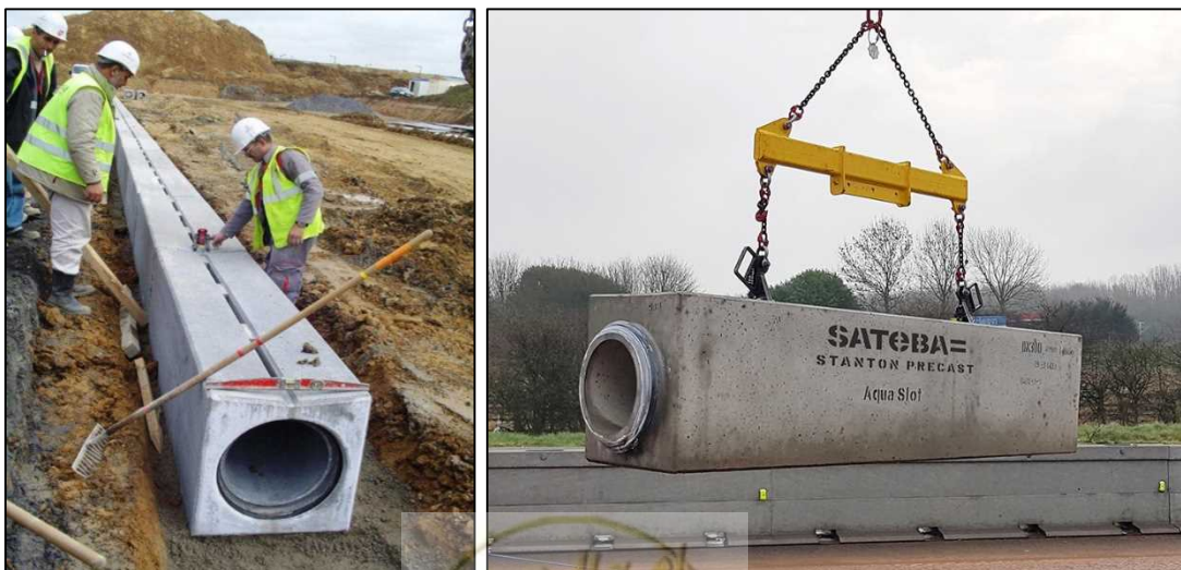
شکل ۵۳: نحوه حمل و نصب کانال پیش‌ساخته خطی
