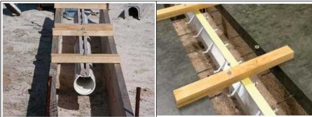
شکل ۵۵: روش مهار زهکش خطی (اسلات) با چوب و بولت قبل از بتن‌ریزی
