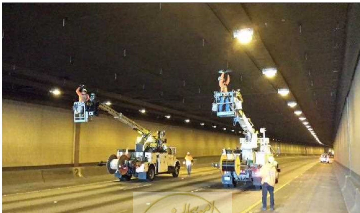
شکل ۷-۳ بازرسی پوشش تونل با استفاده از بالا بر
