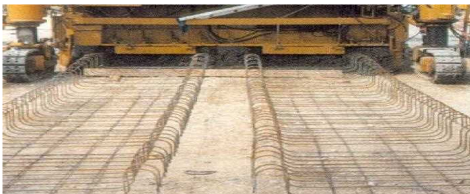
شکل ۲-۱۱ اجرای آرماتور دال بستر سیستم والو
