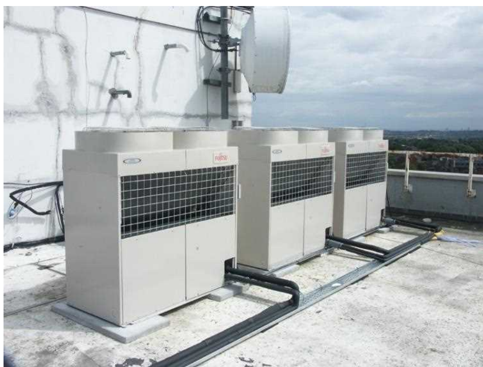
شکل ۴- نمای کندانسینگ یونیت خارجی سیستم VRF
