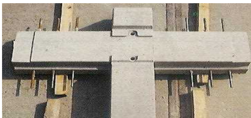
شکل ۲-۲۹ تصویری از سیستم خط قابی شکل کوکن
