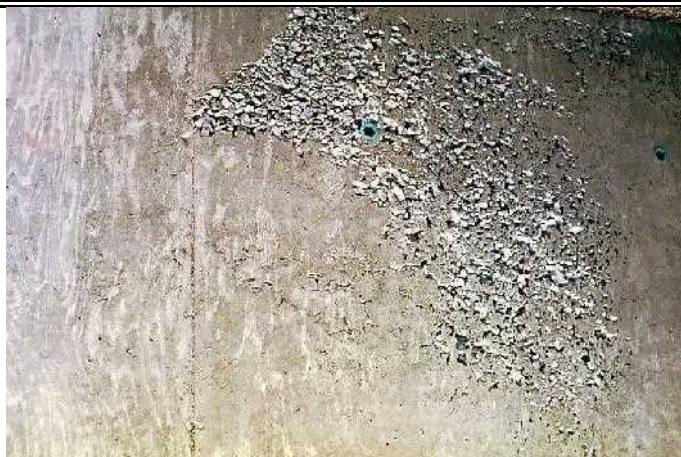
شکل ۴۲ → نمونه بتن لانه زنبوری
