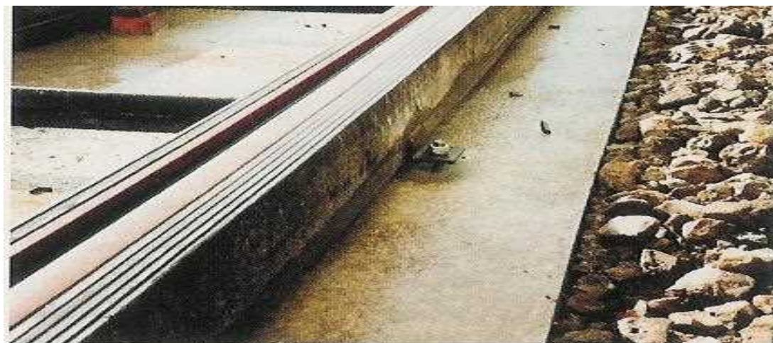
شکل ۲-۳۳ قاب خط مونتاژ شده آماده اجرای روسازی آسفالتی
