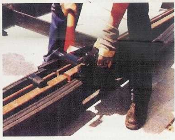
شکل ۲-۳۲ نصب پرکننده‌های جان
