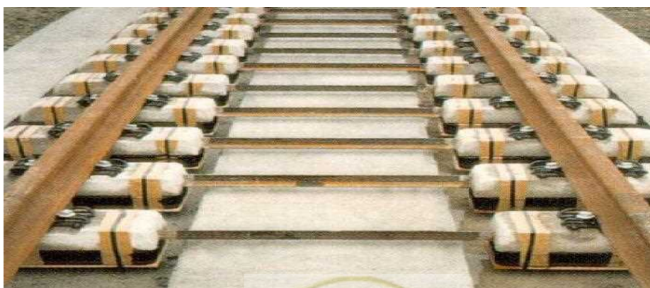
شکل ۲-۱۲ نصب تراورسها در بستر سیستم والو
