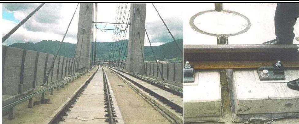
شکل ۲-۲۱ نمونه اجرا شده دال خط شینکانس
