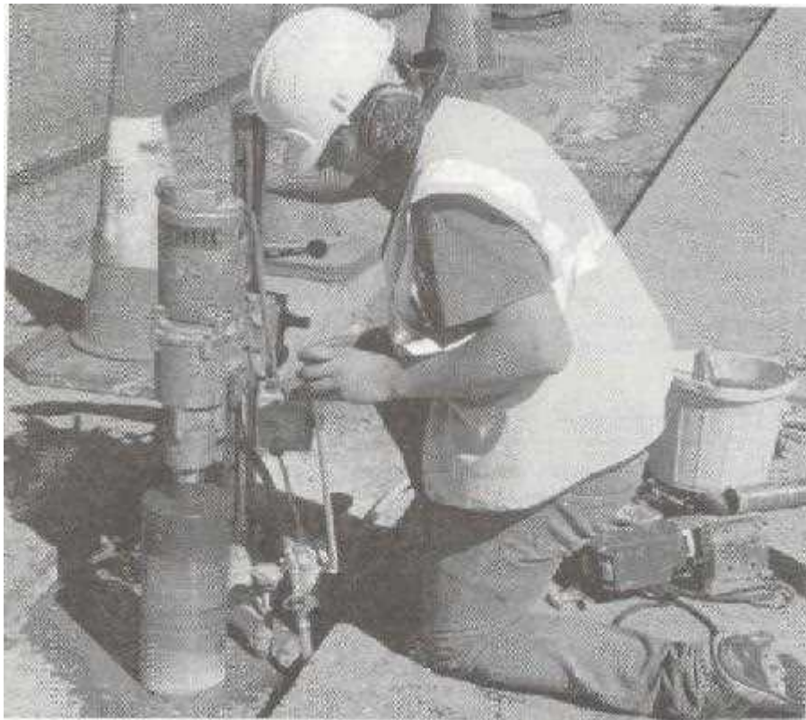
شکل ۵-۴ تنظیمات کلی آزمایش مغزه‌گیری از بتن
