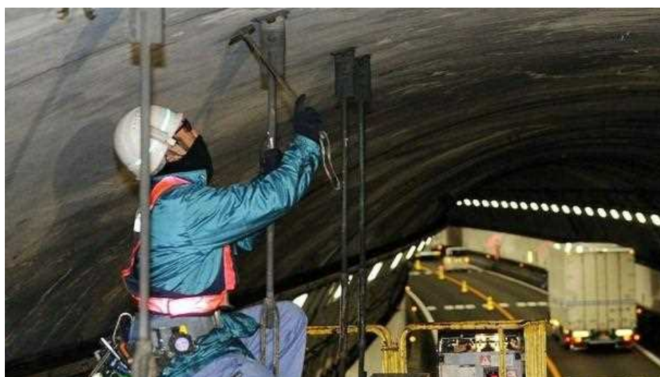
شکل ۱۰-۴ انجام چکش‌زنی بر روی سطوح فوقانی تونل
