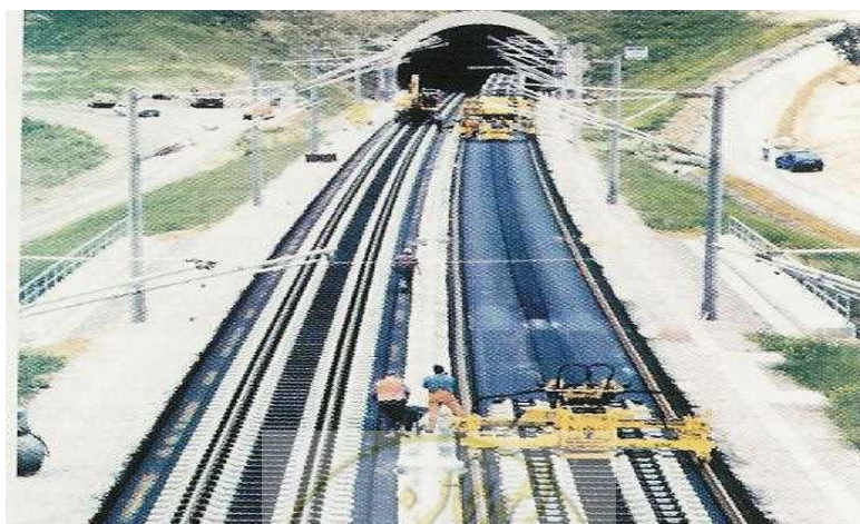
شکل ۲-۱۳ روسازی بتن آسفالتی در دست ساخت
