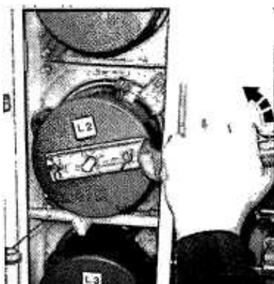
شکل ۴-۱۲۴ مراحل تعویض فیوز
