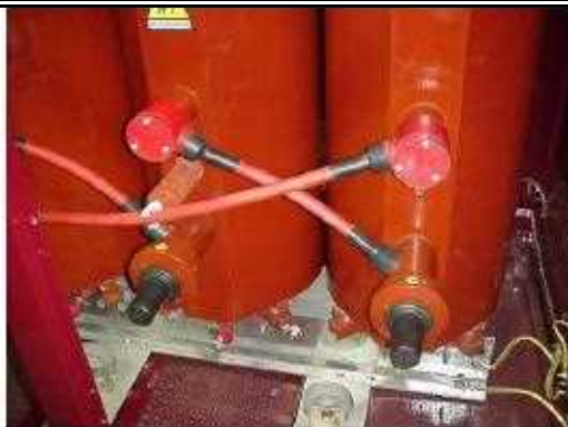
شکل ۴-۵ پوشینگ ترمینال فشار قوی
