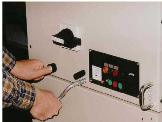
شکل ۱۹- تغییر وضعیت کلید به Disconnect
