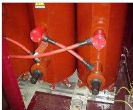
شکل ۵- پوشینگ ترمینال فشار قوی
