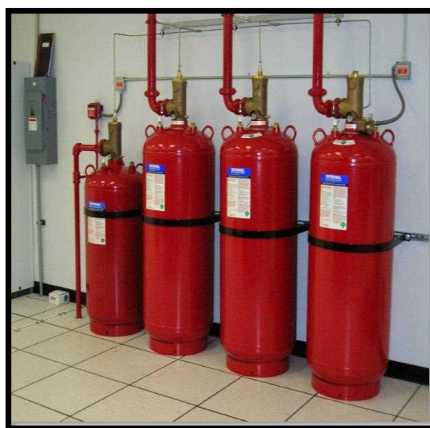
شکل ۴-۲ سیلندرهای اطفای گازی
