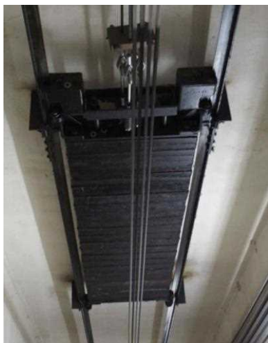
نمایی از قاب وزنه و وزنه‌های تعادل
