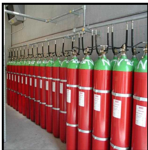
شکل ۴-۲ سیلندرهای اطفای گازی
