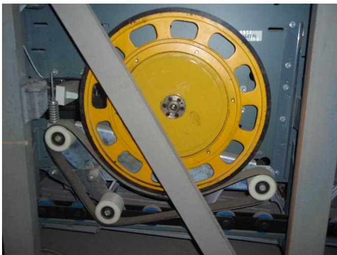
شکل ۲-۲ سیستم کشنده هندریل
