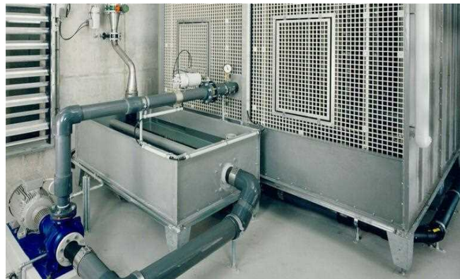
شکل ۳-۴-۱ حوضچه هواسازهای ایستگاهی و تونلی
