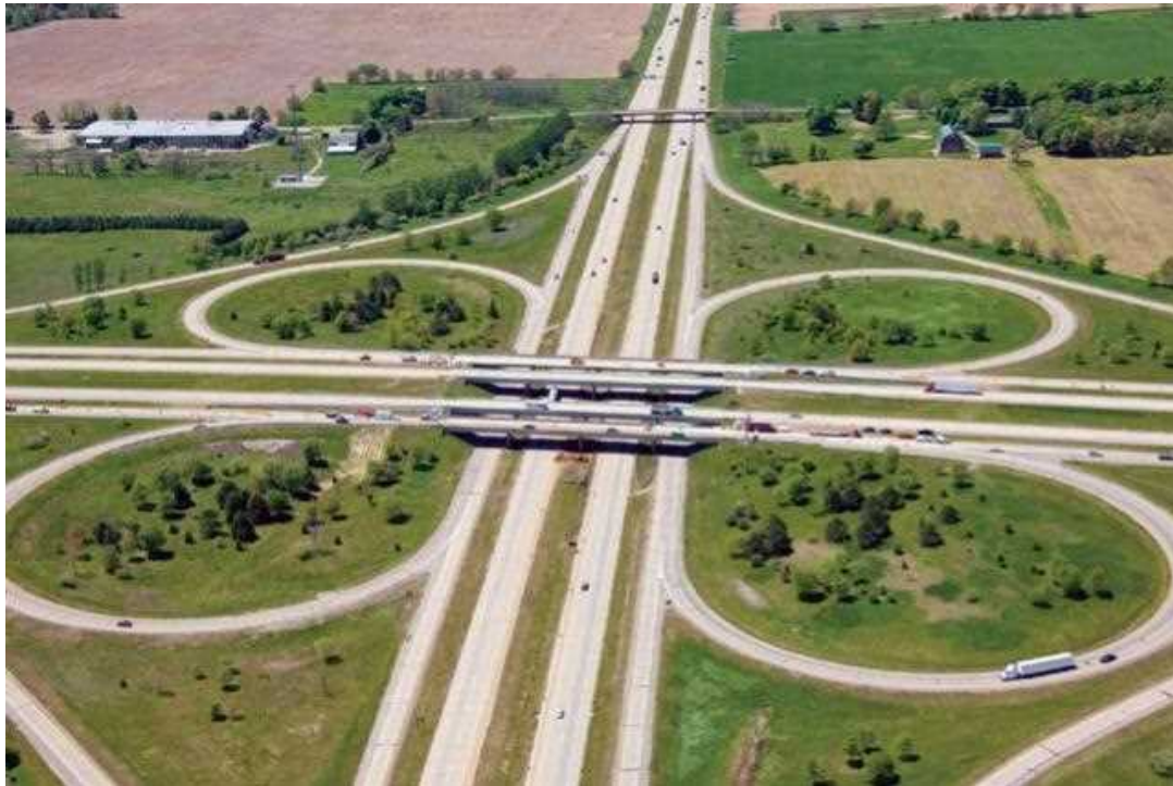
شکل ۶-۲۹- تبادل شبدری کامل با راه‌های جمع‌کننده-توزیع‌کننده
