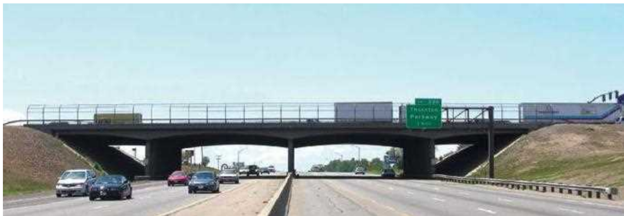
شکل ۳-۶- نمونه سازه غیرهمسطح با کوله باز
