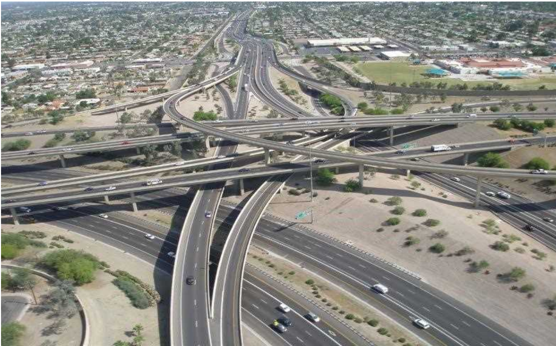
شکل ۶-۳۸- تبادل جهتی چهار سطحی
