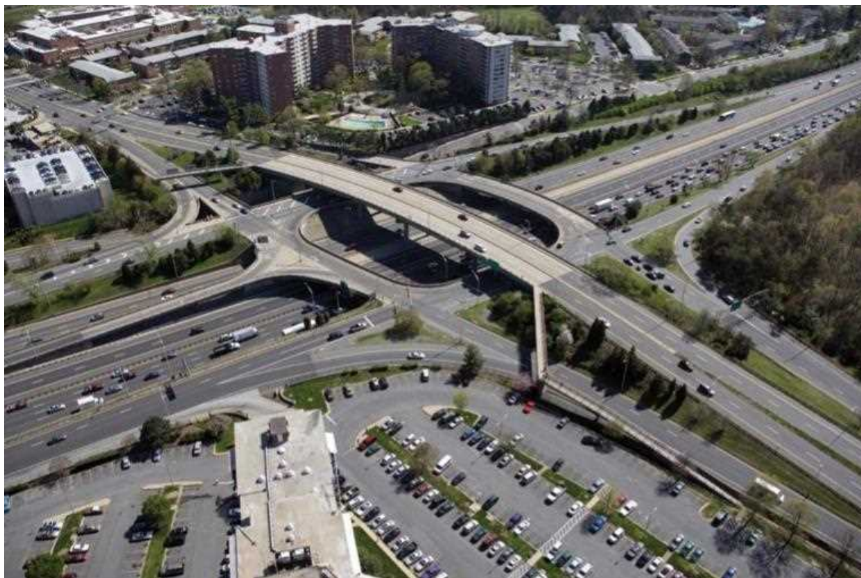
شکل ۶-۲۰- آزادراه با یک تبادل لوزوی سه طبقه
