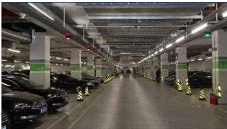
شکل ۳-۱۷- نمایشگرهای نشان‌دهنده در دسترس بودن یا اشغال بودن پارکینگ
