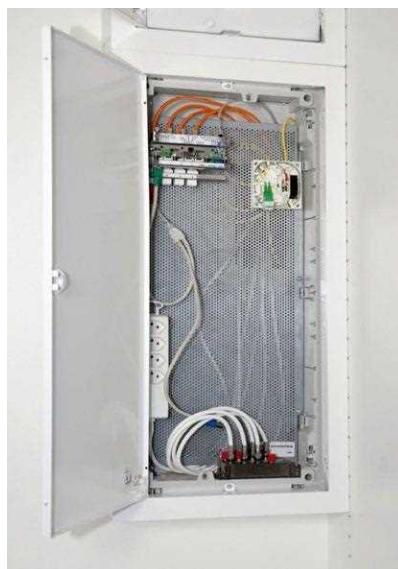
شکل ۲-۱۳- OTO در یک جعبه توزیع درون واحد یکپارچه‌شده
