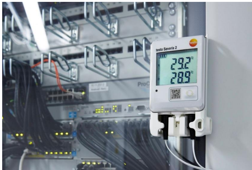
شکل ۴-۷- استفاده از حسگرها در نزدیکترین فاصله از مصرف‌کننده
