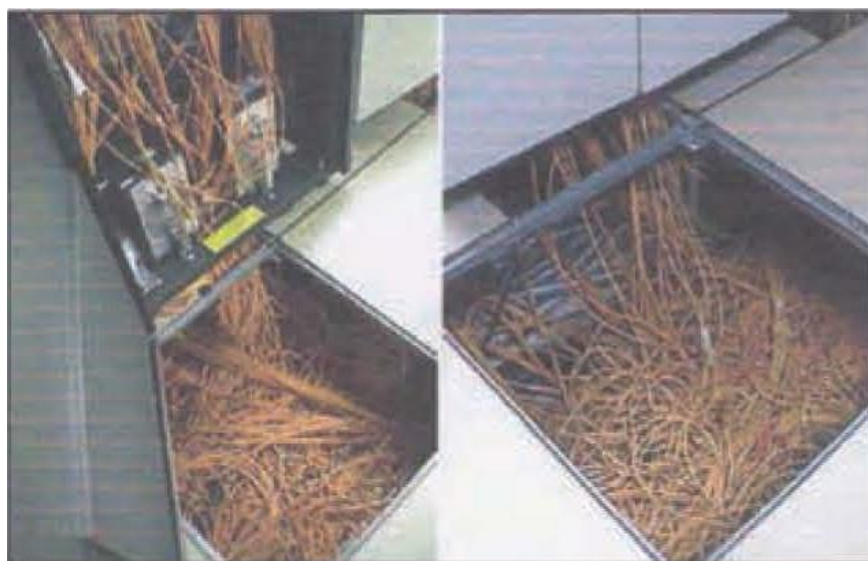
شکل ۵-۲- نمونه‌ای از کابل‌کشی نقطه به نقطه
