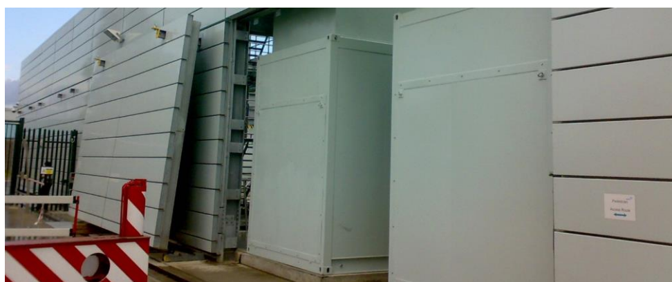
شکل ۶-۸- دیوار کنترل‌کننده نویز خارجی
