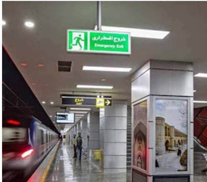
شکل پ ۳-۱۶ نمونه تابلو خروج اضطراری
