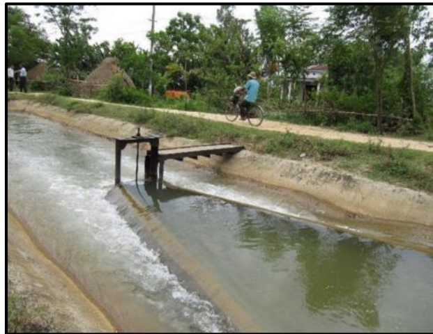
شکل ۳-۱۶- سرریز لبه طولانی از نوع نوک‌مرغابی
