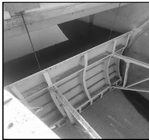
شکل ۳-۱۳- دید پایین‌دست دریچه‌های قطاعی - شبکه آبیاری ورامین
