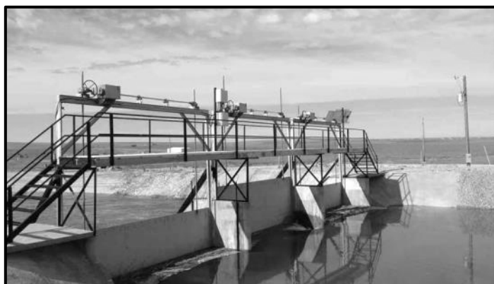
شکل ۹-۴- نمونه‌ای از یک نقطه کنترلی شامل سه دریچه کشویی خودکار موازی و سرریزهای جانبی در دو طرف
