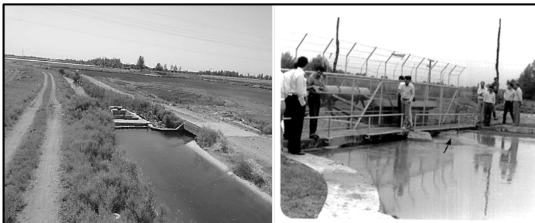
شکل ۳-۱۸- نمای بالادست دریچه آمیل در شبکه سفید رود گیلان (راست) و شبکه آبیاری قزوبین (چپ)
