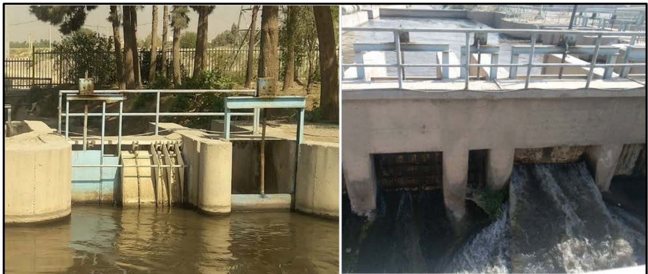
شکل ۳-۷- دریچه‌های کشویی با جعبه دنده دستی به صورت موازی در شبکه ورامین
