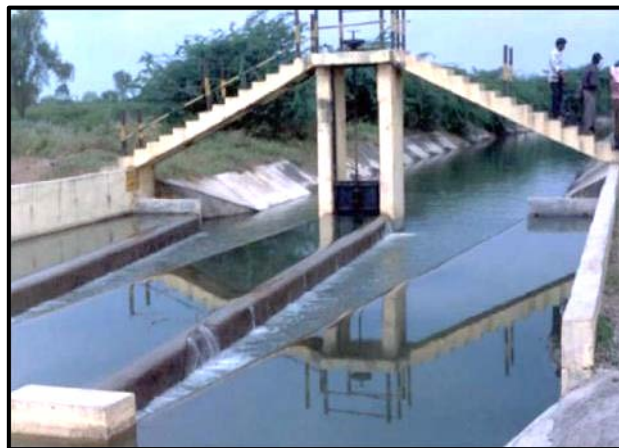
شکل ۳-۱۵- یک سرریز لبه طولانی با دریچه پاک‌سازی رسوب در انتهای میانه پایین دست
