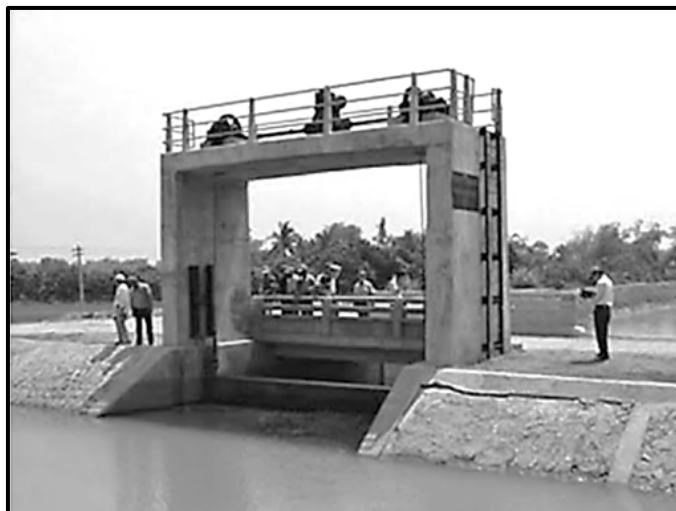
شکل ۳-۸- یک دریچه کشویی خودکار بزرگ در تایلند
