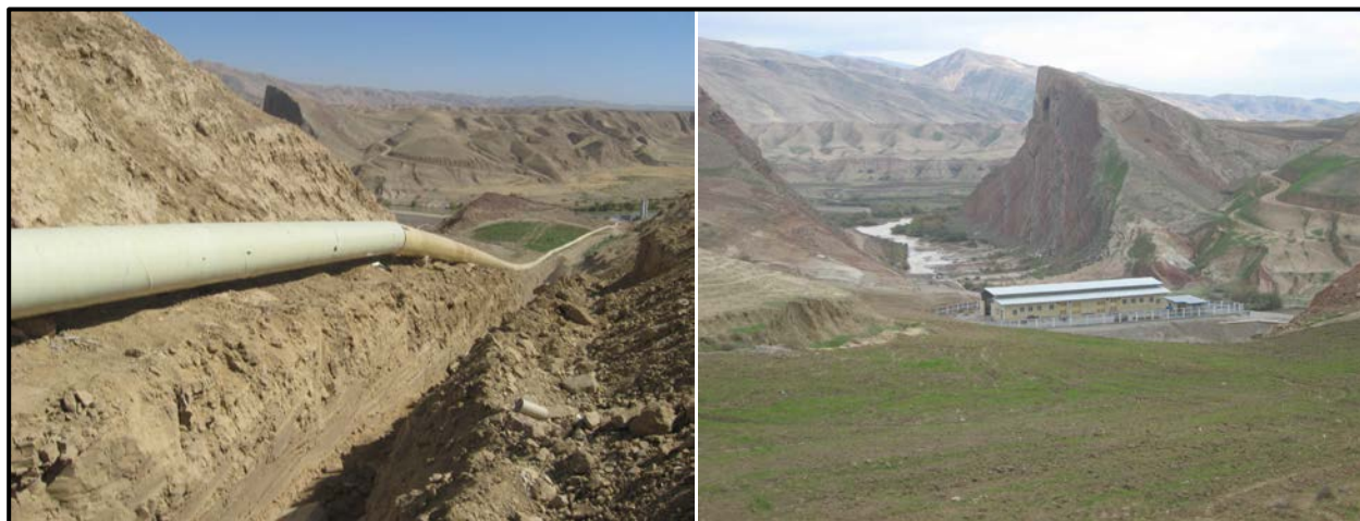
شکل پ.۱-۱۰- ایستگاه پمپاژ و خط لوله انتقال به ارتفاع حداقل ۱۵۰ متر از رودخانه سیمره
