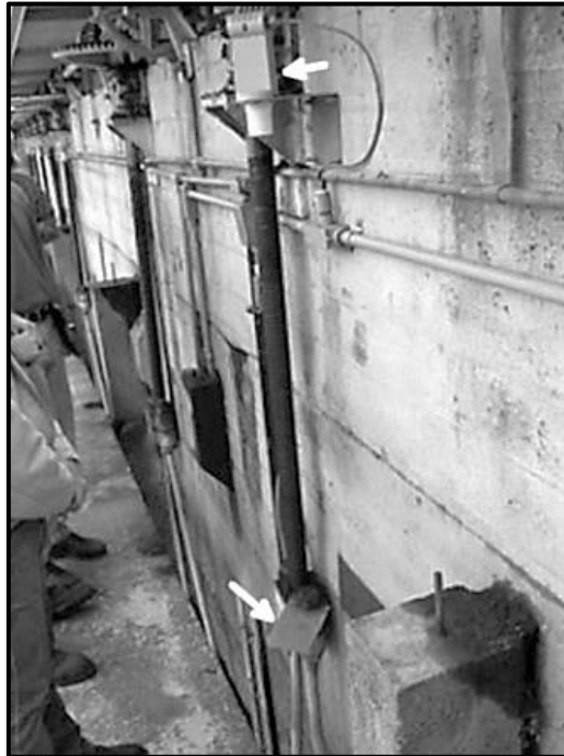
شکل ۳-۳۱- حس گر آلتراسونیک (نشان گر بالا)، ناظر حرکت نشان گر در بجه کشویی (نشان گر پایین)
