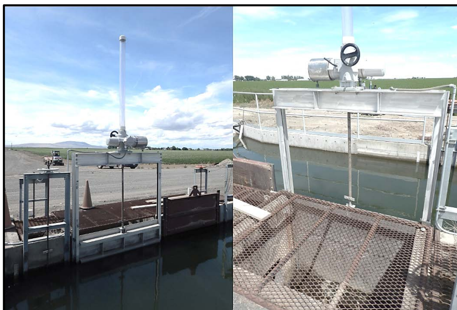
شکل ۳-۱۱- نمونه‌ای از دریچه کشویی خودکار همراه با فرمان دستی
