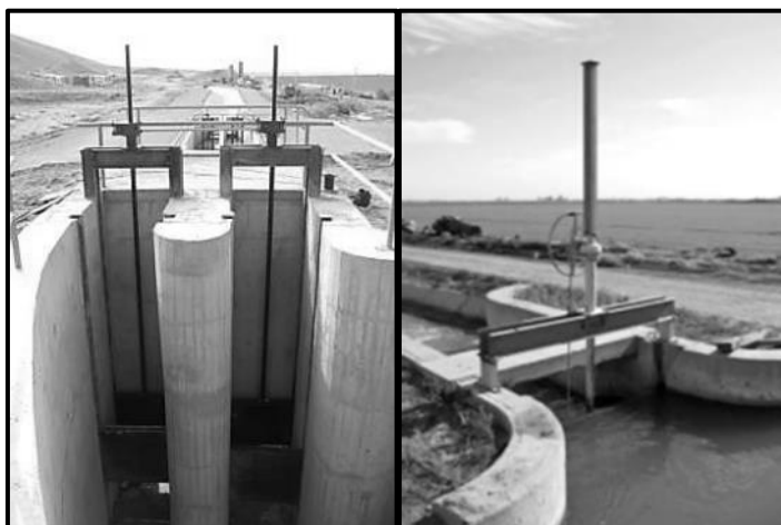
شکل ۳-۹- دریچه کشویی دستی با یک فرمان بزرگ و جعبه‌دنده (چپ) -دریچه کشویی بعد از سازه رسوب‌گیر (راست)
