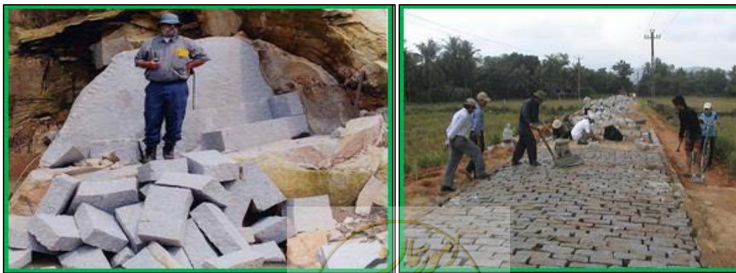
شکل ۶-۲۷- نمونه‌ای از سنگفرش منشوری ملاتی
