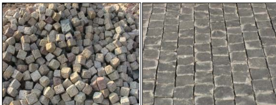
شکل ۶-۲۵- نمونه‌ای از سنگفرش مکعبی منظم
