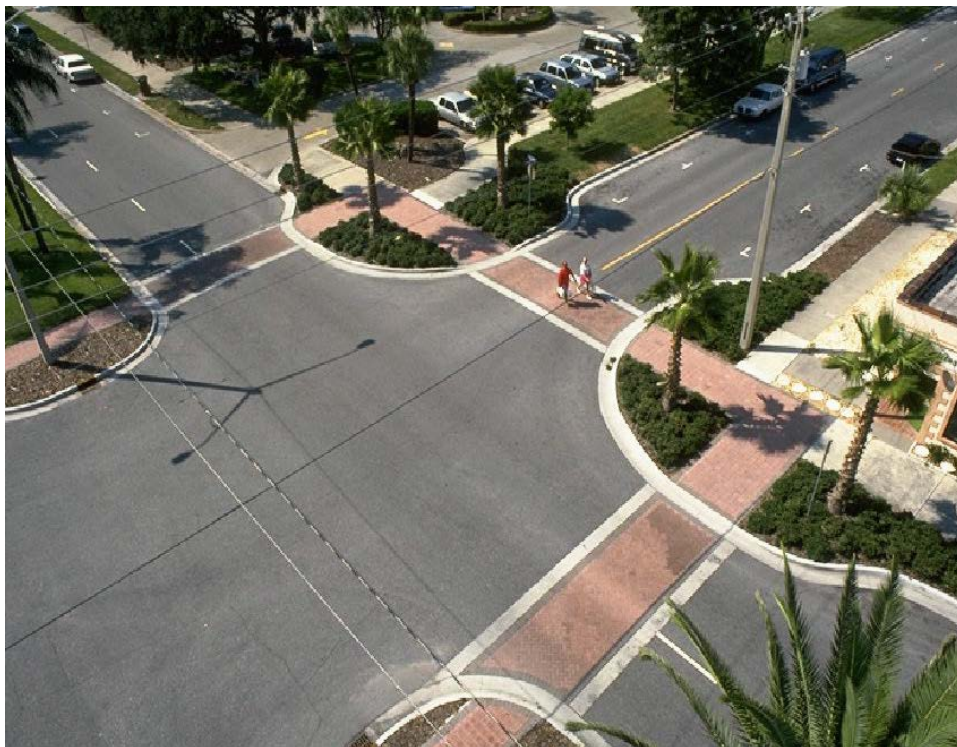
شکل ۳-۸- نمونه پیش‌آمدگی جدول در محل تقاطع
