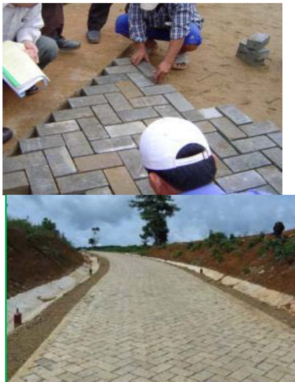
شکل ۶-۳۱- نمونه‌ای از آجر فرش بتنی
