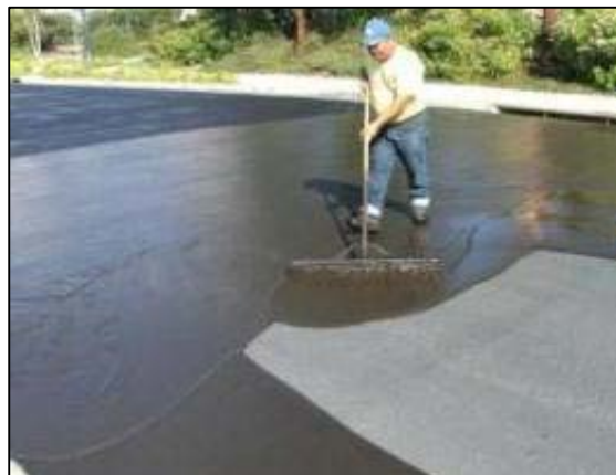
شکل ۶-۱۵- نمونه‌ای از اسلاری سیل
