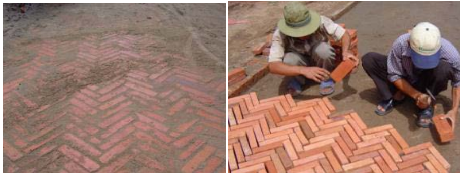
شکل ۶-۲۹- نمونه ای از آجر فرش کوره ای
