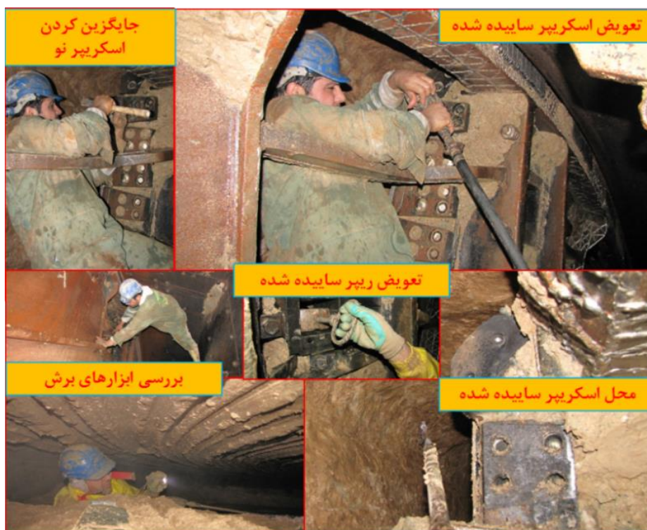
شکل ۲-۱۷: عملیات تعویض ابزارهای برشی در داخل چمبر
