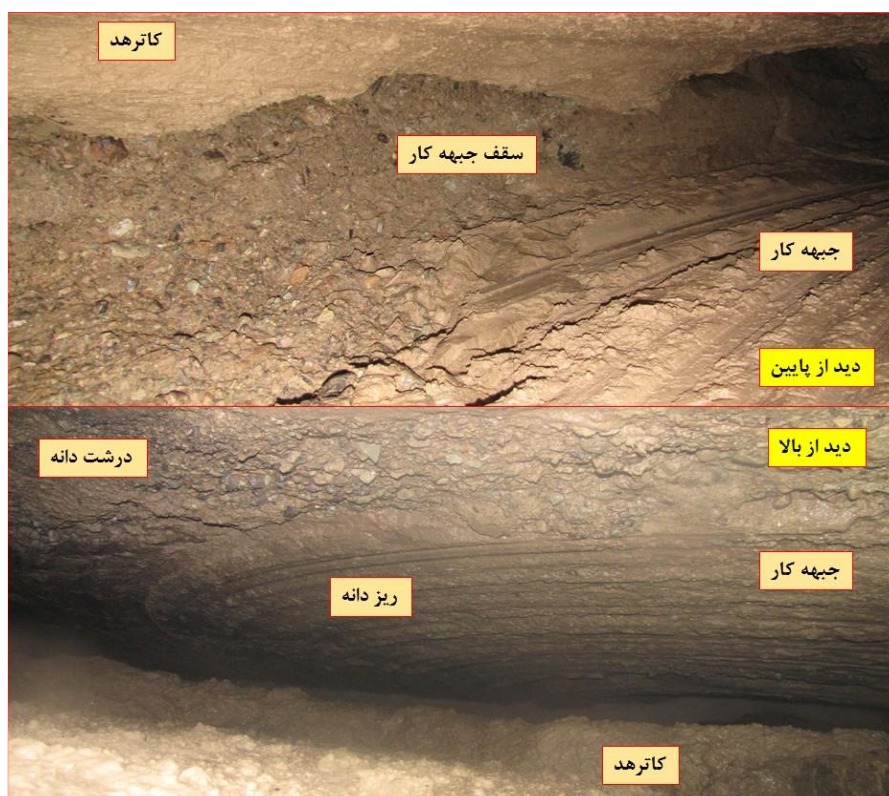
شکل ۲-۲۴: نمایی از جبهه کار مختلط در حین حفاری
