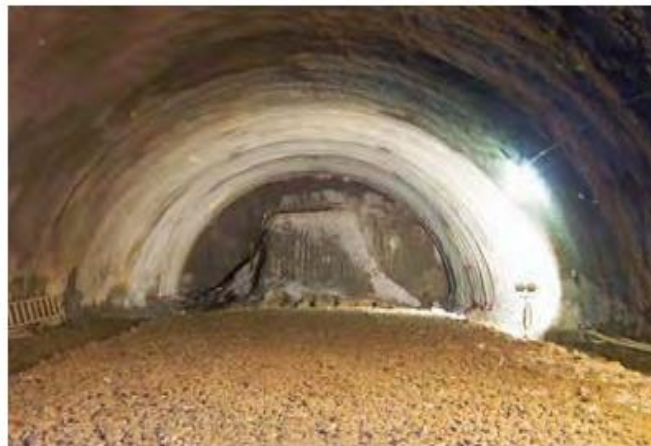
شکل ۳-۱۳: نمونه‌ای از اجرای تونل به روش برش هسته مرکزی (RC)
