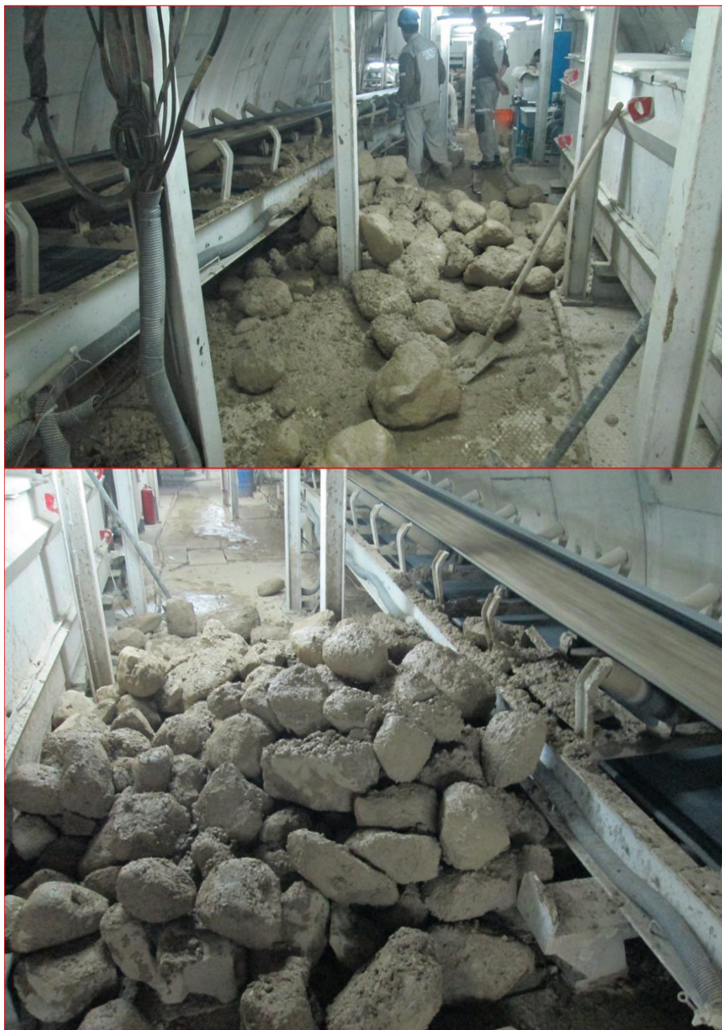
شکل ۲-۲۱: نمایی از بولدرهای حفاری شده توسط ماشین EPB-TBM
