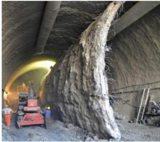
شکل ۳-۱۰: نمایی از اجرای روش دیوار میانی (CD)
