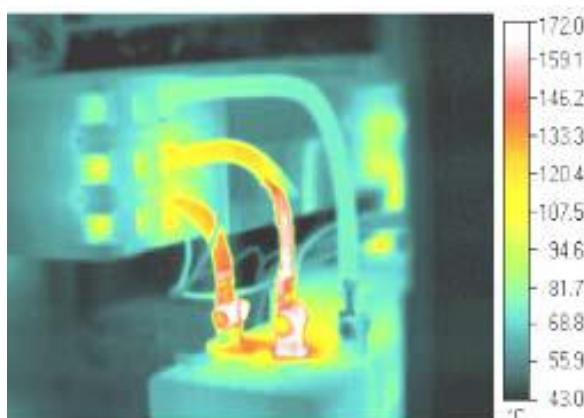
شکل ۶-۳: افزایش مقاومت در اتصال بست که سبب سوختگی عایق کابل شده است.
