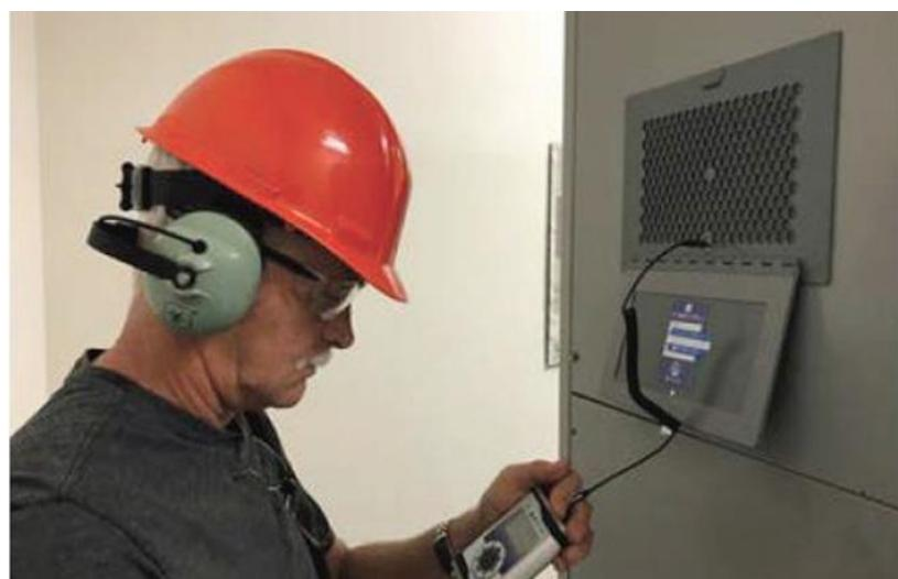
شکل ۲۵-۴: بازرسی سوئیچگیر با یک سنسور تخلیه جزئی نصب شده دائمی مبتنی بر فراصوت
