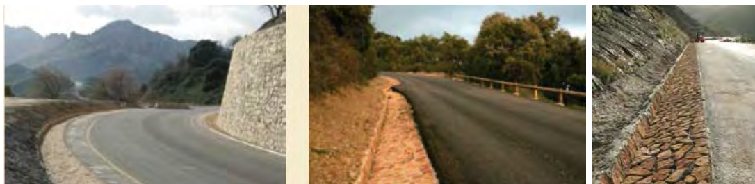
نگاره ۸۴: نمونه راه‌آب با مصالح سنگی
