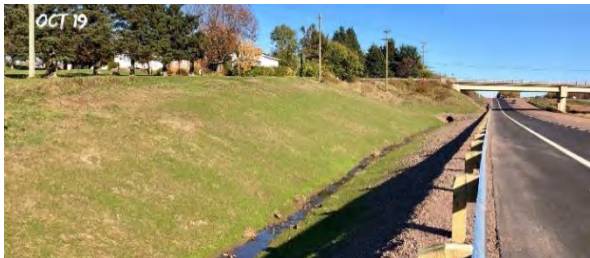
نگاره ۱۷۲: تثبیت ترانشه و راه آب آزهکش طولی به روش بذرپاشی دوغابی
