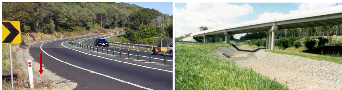
نگاره ۸۳: راست: آبروی خطی با بستر پوشیده از سنگ، استرالیا؛ چپ: کانپو ۱ جمع‌آوری آب سطح جاده پاسیفیک، نیوولز جنوبی استرالیا
