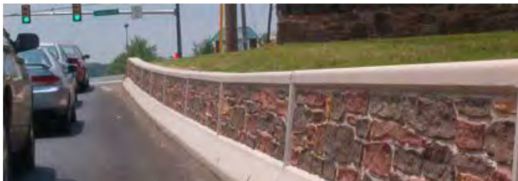
نگاره ۷۲: بافت رنگی با طرح سنگ حفاظ بتنی، پنسیلوانیا
