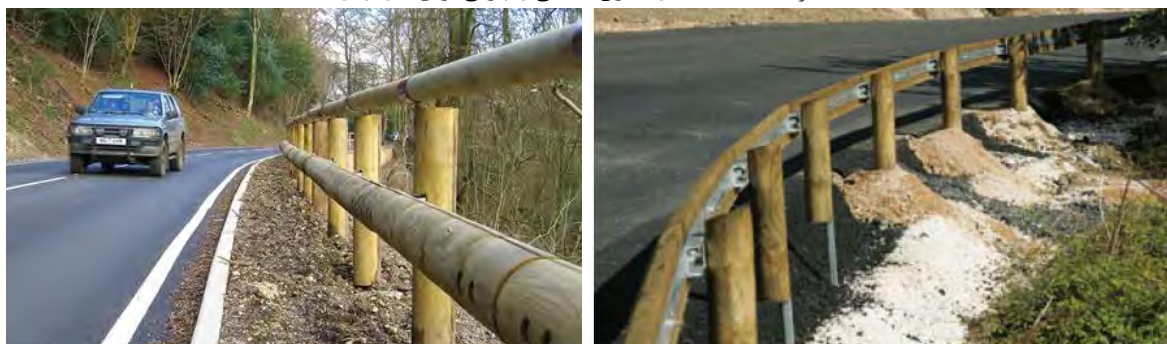
نگاره ۶۸: پوشش گاردریل از چوب منعطف
