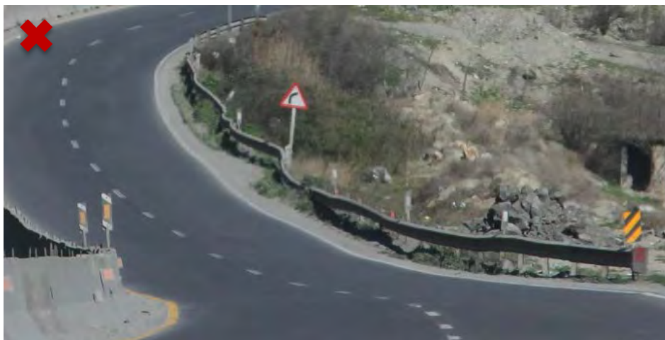
نگاره ۱۹۶: ضرورت رسیدگی دوره‌ای، تعمیر و تعویض حفاظ‌های آسیب‌دیده
