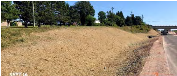
نگاره ۱۷۲: تثبیت ترانشه و راه آب آزهکش طولی به روش بذرپاشی دوغابی
