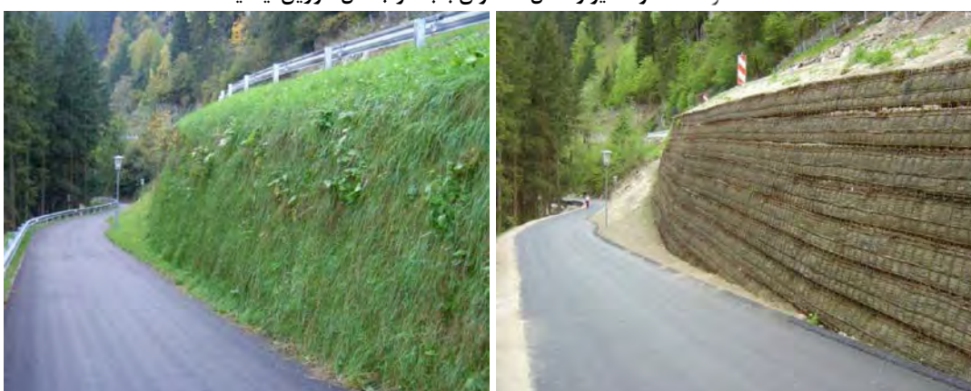
نگاره ۵۵: نمونه دیوار حائل همخوان با طبیعت به روش خاک مسلح، آلمان
