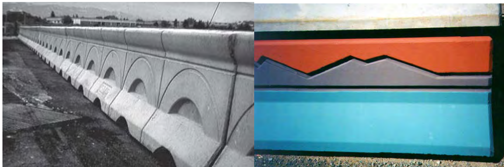
نگاره ۷۱: راست: حفاظ بتنی طرح‌دار با تم محیط و رنگ‌های روشن، تگزاس، چپ: نیوجرسی با طرح قوس، هماهنگ با معماری رُم
