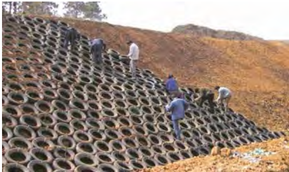
نگاره ۱۷۱: تثبیت ترانشه با اجرای ژئوسل یا تایرهای مستعمل - چین
