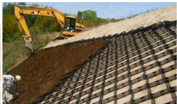
نگاره ۱۷۱: تثبیت ترانشه با اجرای ژئوسل یا تایرهای مستعمل - چین
