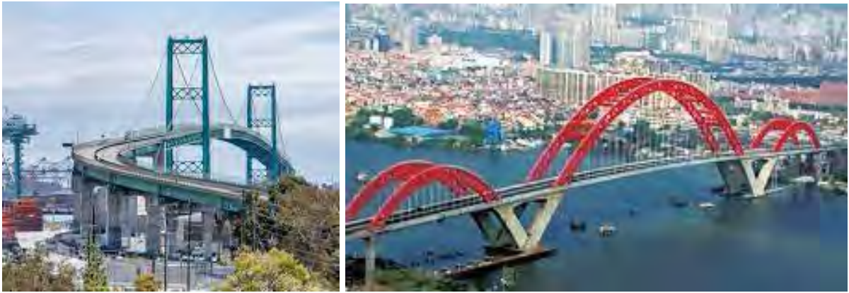
نگاره ۱۲۵: استفاده از رنگ برای تقویت فرم پل و خوانایی دید کشتی‌ها، راست: پل زینگوانگ، گانگزو چین، چپ: پل وینسنت لس آنجلس
