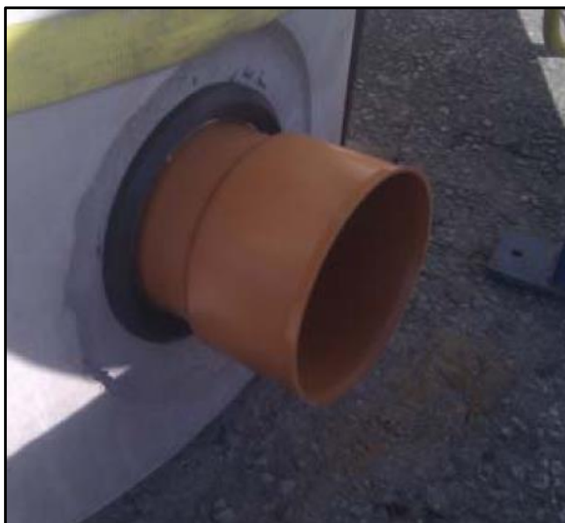
شکل ۴-۹- نمونه اتصال انعطاف پذیر لوله به آدمرو
