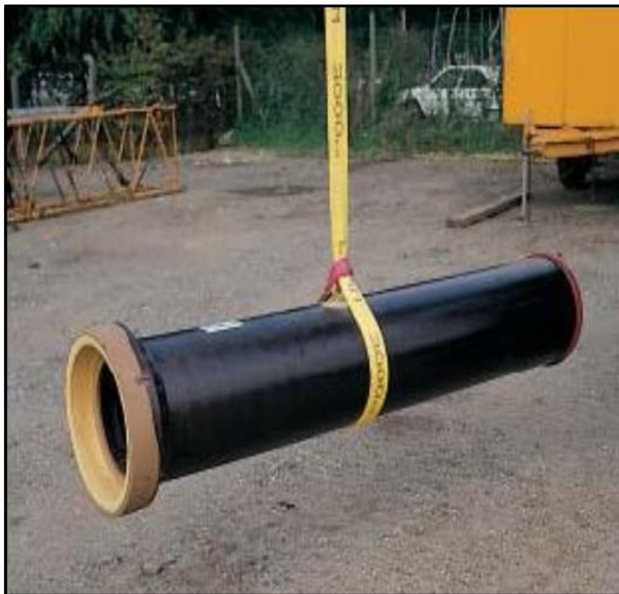
شکل ۲-۳۴- جابه‌جایی به روش یک تسمه‌ای
