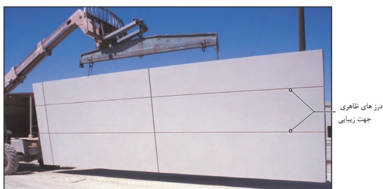
شکل ۱۱-۱۲- الف- سطح بیرونی یک پانل GFRC، در حال حمل در کارگاه
