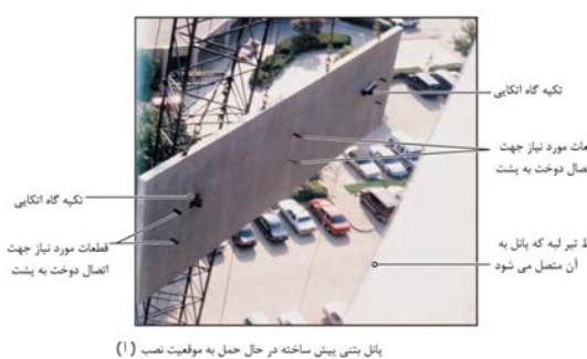
شکل ۱۰-۷- نمونه‌ای از اتصال دوخت به پشت
