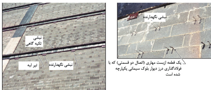
شکل ۵-۲۰- جزئیات اجرایی اتصال نبشی تکیه‌گاهی به دیوار پشتیبان
