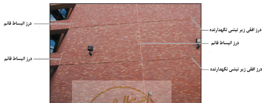
شکل ۵-۱۷- درز انبساطی پیوسته در نمای آجری
