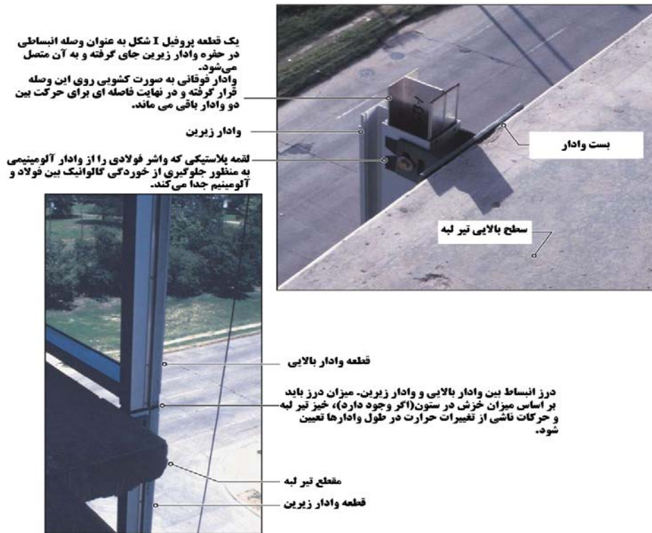
شکل ۹-۷- نمونه اتصال انبساطی بین دو قطعه وادار
