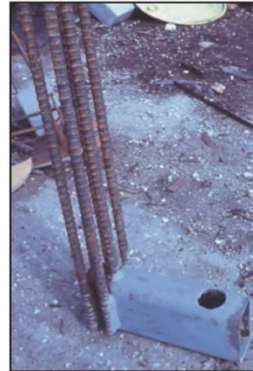
قوطی فولادی جهت تکیه گاه اتکایی (ب)
