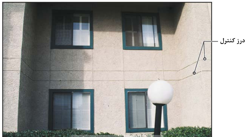
شکل ۶-۲- نمونه درزهای کنترل بر روی نمای سیمانی
