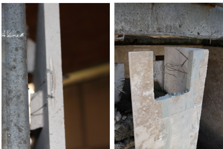
شکل ۴-۲- نمونه‌هایی از مه‌ارهای سیمی فولادی
