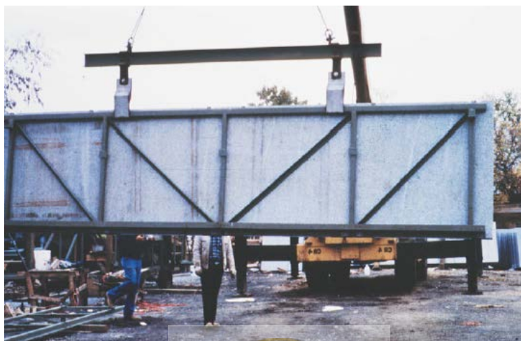
شکل ۴-۲۱- پانل دیواری پرده‌ای پیش ساخته سنگی
