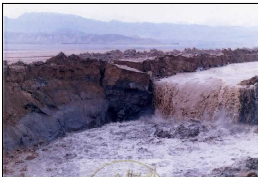
شکل ۶-۱۱- تصویری از فرسایش پس‌رونده در یکی از کانال‌های حفر شده در سد سفیدرود در حین عملیات رسوب‌زدایی [۳]
