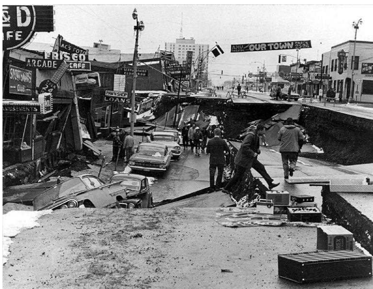
شکل ۱-۳- فروریزش بخشی از خیابان در شهر Anchorage در طی زلزله‌ی آلاسکا
