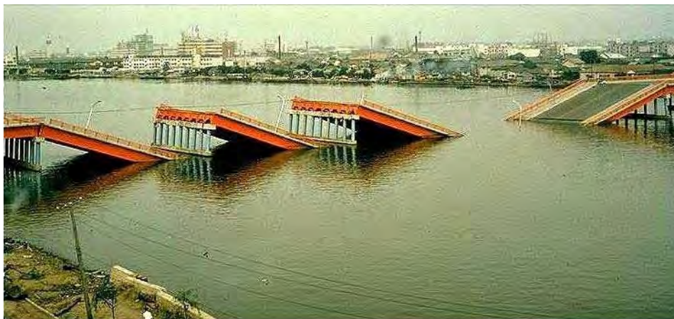
شکل ۱-۷- خرابی پل Showa در اثر روانگرایی در زلزله‌ی نیگاتا
