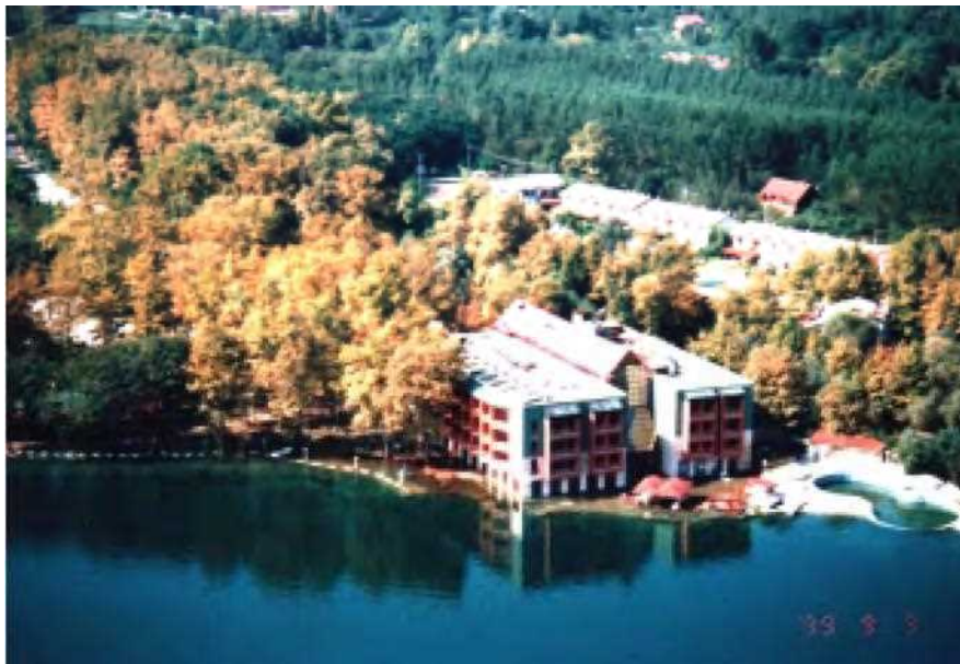
شکل ۱-۱۴- گسترش جانبی و نشست هتل در طول ساحل دریاچه‌ی Sapanca در زلزله‌ی Kocaeli
