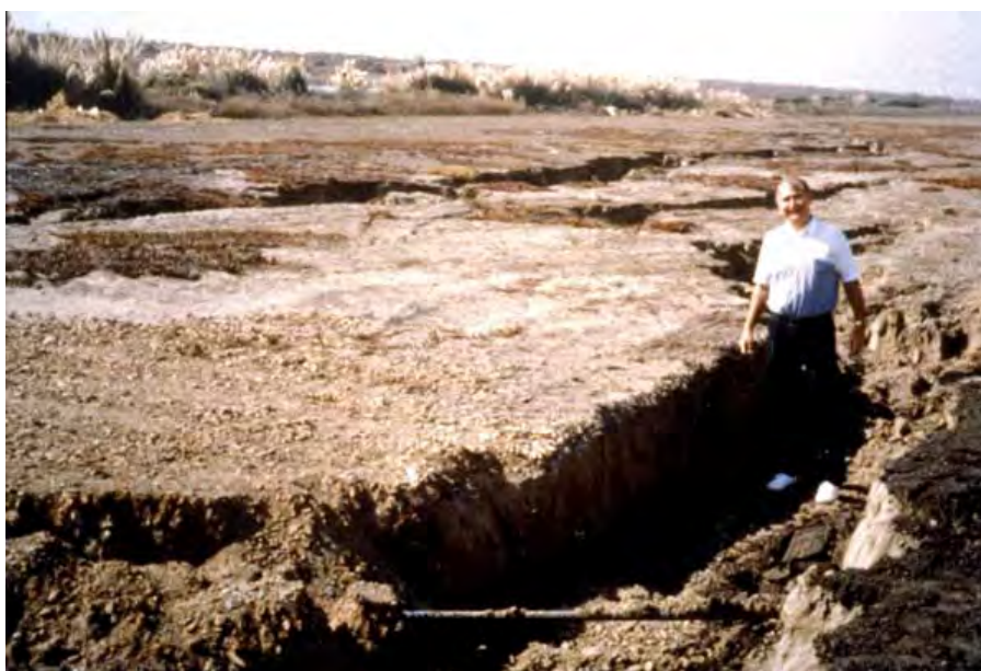
شکل ۲-۵- فرورفتگی زمین در اثر وقوع گسترش جانبی در طی زلزله‌ی سال ۱۹۸۹ Loma Prieta
