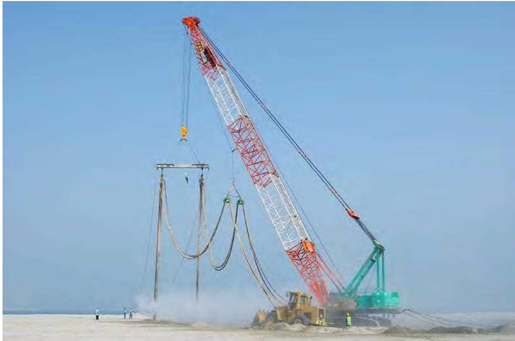
شکل ۸-۸- وسیله‌ی ارتعاشی آویزان از یک جرثقیل معمولی
