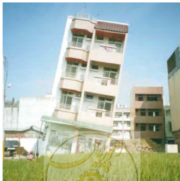
شکل ۱-۱۵- گسیختگی پی در اثر روانگرایی در شهر Yuanlin در زلزله‌ی Chi Chi
