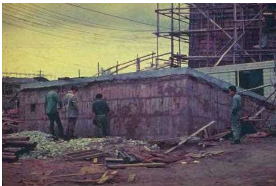
شکل ۲-۱۱- بیرون‌زدگی مخزن بتنی از زمین در اثر روانگرایی خاک اطراف مخزن در زلزله‌ی سال ۱۹۶۴ نیگاتا
