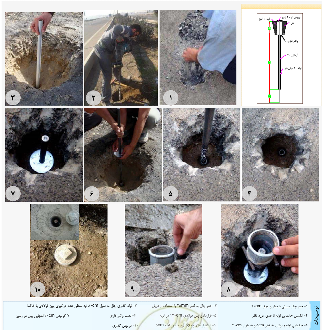
شکل ۵-۳- مراحل نصب پین نشست‌سنجی
