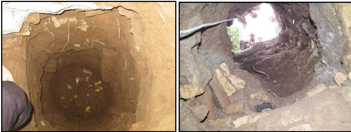
شکل پ.۹-۴- تصاویر مجرای فاضلاب قدیمی شناسایی شده در محدوده پین تراز یابی LS.LP.02.C5 پروژه خط ۷ مترو تهران
