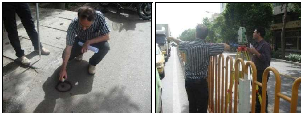
شکل ۲-۳- تصاویری از عملیات پیاده‌سازی ابزار دقیق در سطح زمین
